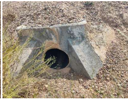
Foto nº8.: Drenaje (orientación sur) de vial de acceso PE-02.
