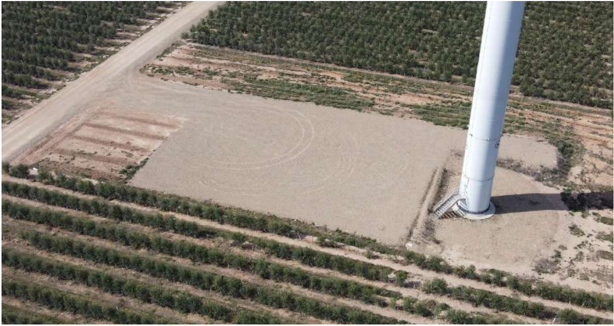
Foto nº5.: Plataforma del Aerogenerador PE-05.
