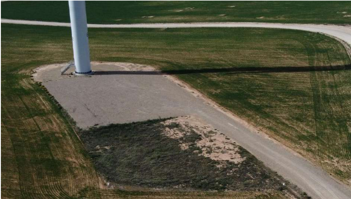
Foto nº1.: Plataforma del Aerogenerador PE-01.
