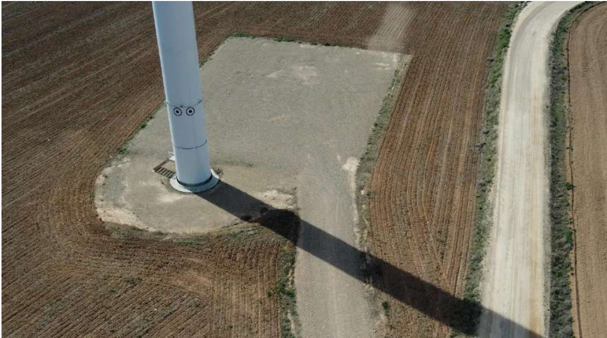
Foto nº3.: Plataforma del Aerogenerador PE-03.
