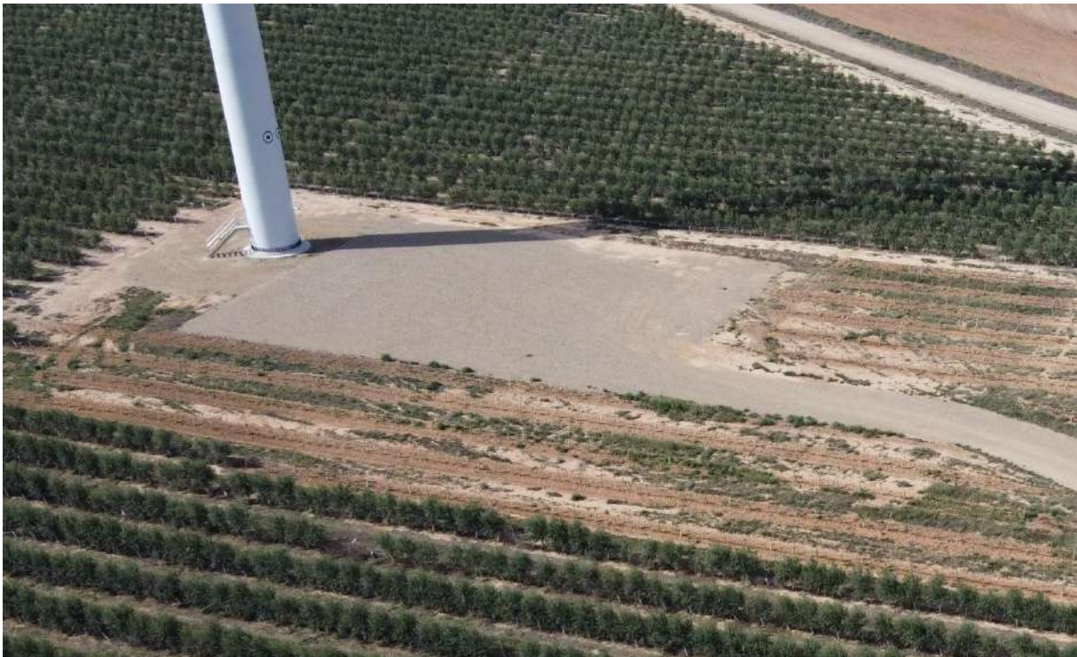
Foto nº4.: Plataforma del Aerogenerador PE-04.
