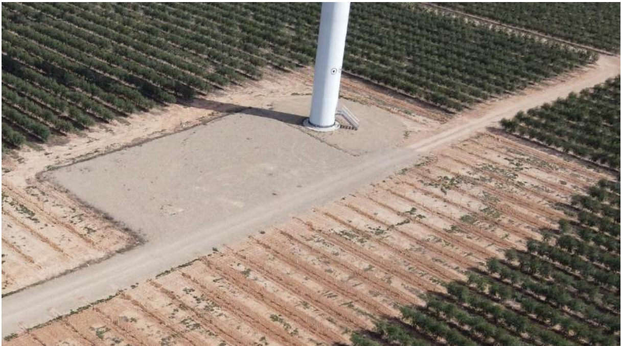
Foto nº6.: Plataforma del Aerogenerador PE-06.
