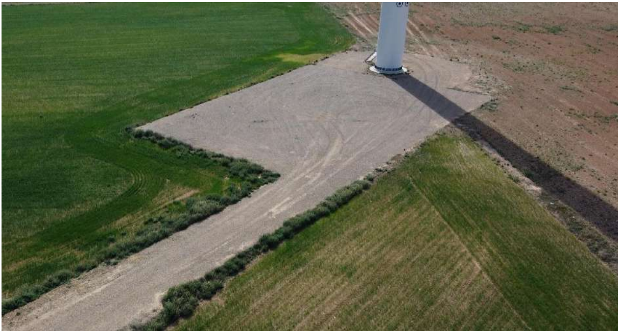
Foto nº2.: Plataforma del Aerogenerador PE-02.
