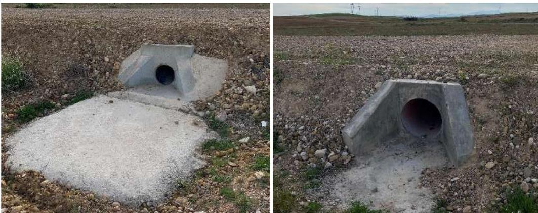
Foto nº11.: Drenaje (orientación norte) de vial de acceso PE-02.
