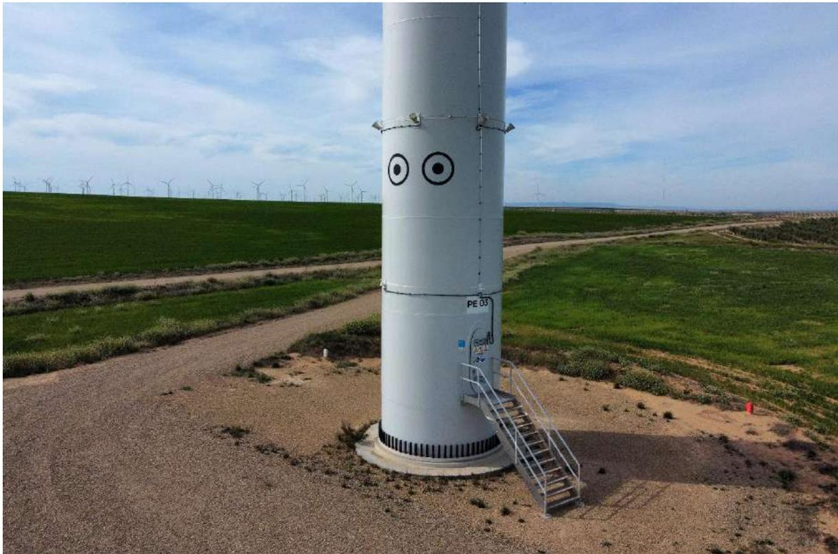
**Foto n°7.:** Dispositivo DTBird, y pintado “ojos de búho” en PE-03.
