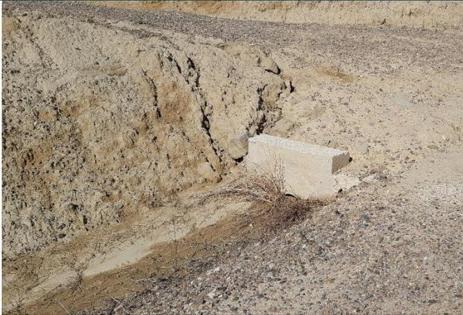
Fig. 1 Tubo de drenaje semitaponado con sedimentos en vial de acceso al aero ML5.09. Fuente: Elaboración propia
