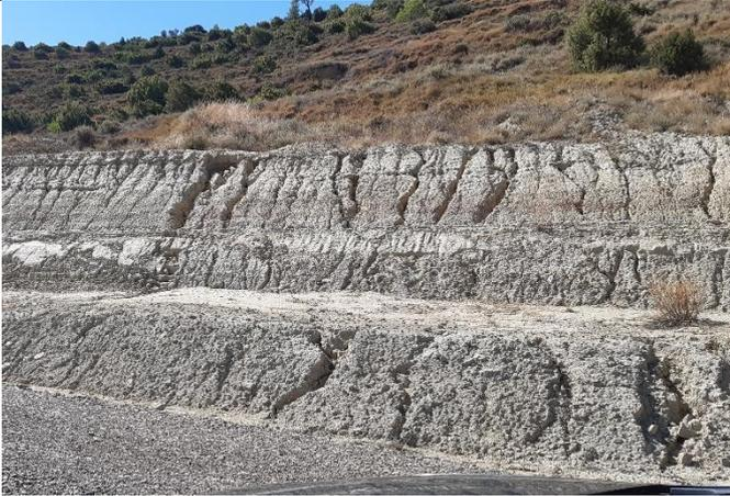
Fig. 1 Erosión hídrica en materiales margo-calizos del talud de desmorte del vial de acceso a ML5.05. Fuente: Elaboración propia
