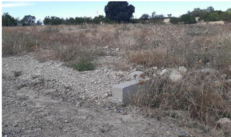
Fig. 3 Tubo de drenaje taponado por vegetación arbustiva y sedimentos en vial de acceso al aero ML5.01. Fuente: Elaboración propia
