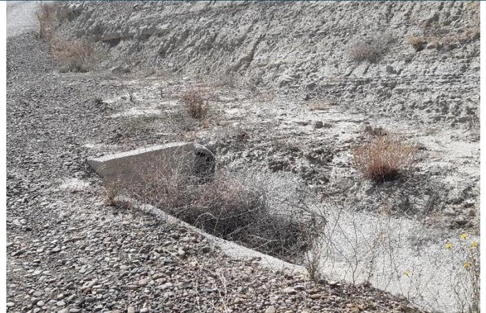
Fig. 2 Tubo de drenaje semitaponado con vegetación arbustiva en vial de acceso al aero ML5.05. Fuente: Elaboración propia
