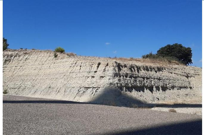
Fig. 2 Erosión hídrica en materiales margo-calizos del talud de desmorte de la plataforma del aero MLA5.07. Fuente: Elaboración propia
