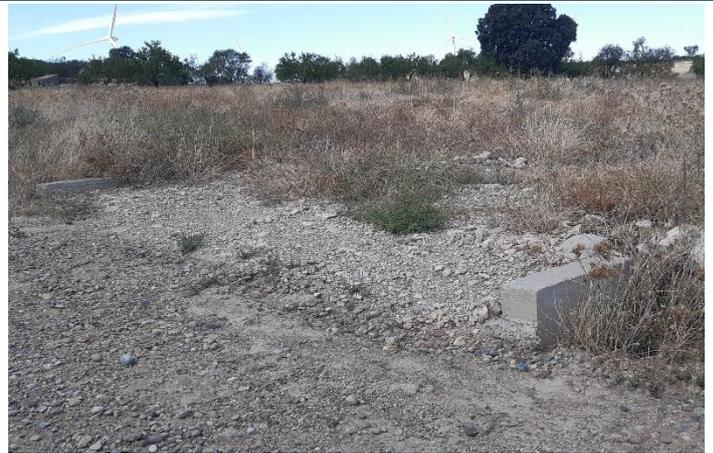
Fig. 2 Tubo de drenaje taponado por vegetación arbustiva y sedimentos en vial de acceso al aero ML4.04. Fuente: Elaboración propia
