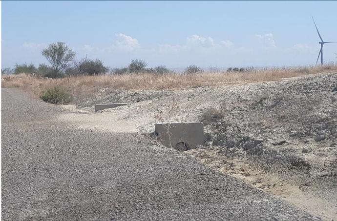
Fig. 1 Tubo de drenaje semitaponado con sedimentos en vial de acceso al aero ML4.07. Fuente: Elaboración propia
