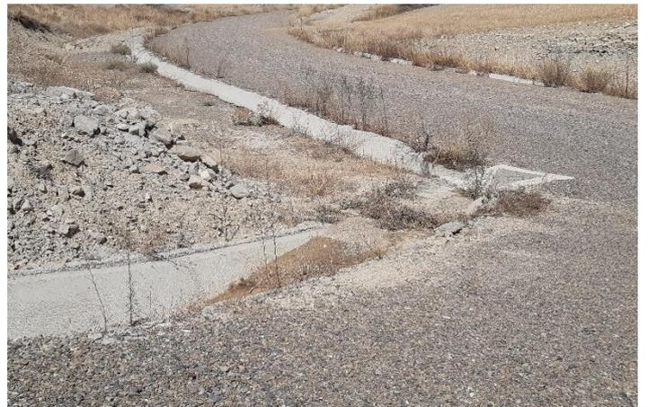
Fig.4 Cuneta llena de sedimentos en vial de acceso al aero ML4.03. Fuente: Elaboración propia
