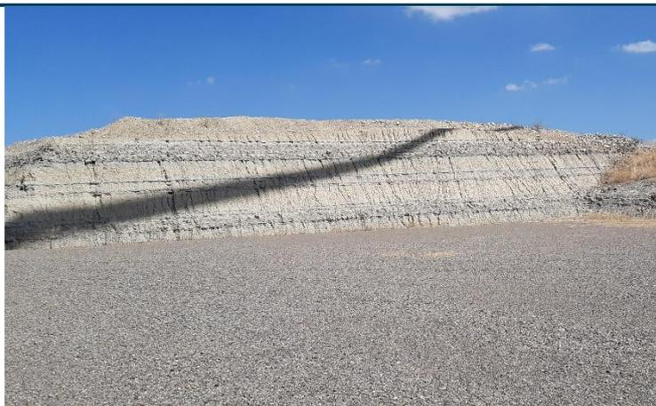
Fig. 1 Erosión hídrica en materiales margosos del talud de desmonte de la plataforma del aero ML4.05. Fuente: Elaboración propia
