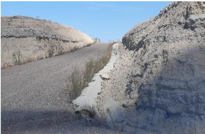
Fig. 3 Cuneta llena de sedimentos en vial de acceso al aero ML4.05. Fuente: Elaboración propia
