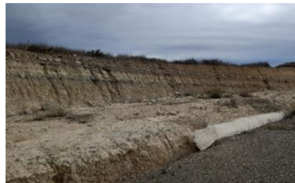
Fig. 2 Erosión hídrica en materiales margo-lutíticos del talud de desmonte del vial de acceso al aero ML1.07.
