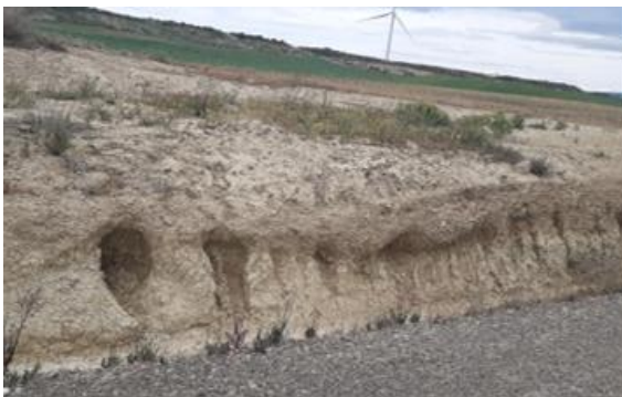
Fig. 1 Erosión hídrica en materiales margosos del talud de desmonte del vial de acceso al aero ML1.01.
