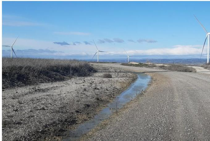
Fig. 3 Encharcamiento en margen de vial de acceso al aero ML1.12. Fuente: Elaboración propia
