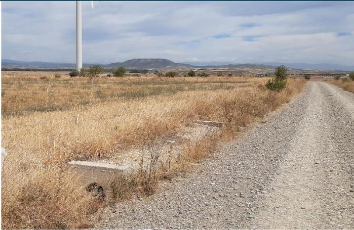
Fig. 1 Tubos de drenaje semitaponado con vegetación arbustiva en vial de acceso al aero ML1.15. Fuente: Elaboración propia
