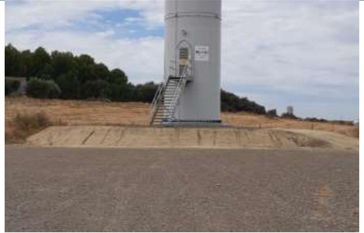
Fig. 2. Erosión hídrica en cimentación del aero ML1.03. Fuente: Elaboración propia
