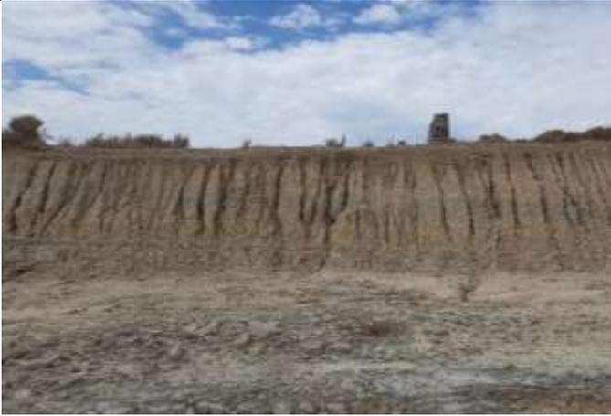
Fig. 1. Erosión hídrica en materiales margo-arenosos del talud de desmonte del vial de acceso al aero ML1.07. Elaboración propia
