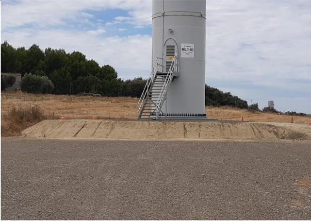
Fig. 1 Erosión hídrica en cimentación del aero ML1.03. Fuente: Elaboración propia
