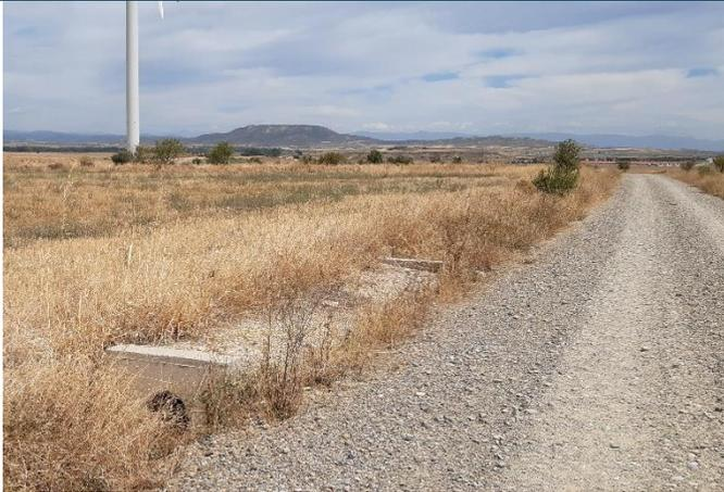
Fig. 1 Tubos de drenaje semitaponado con vegetación arbustiva en vial de acceso al aero ML1.15. Fuente: Elaboración propia
