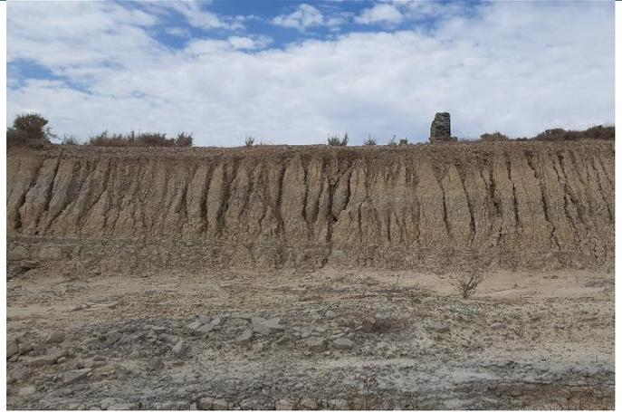
Fig. 2 Erosión hídrica en materiales margo-arenosos del talud de desmonte del vial de acceso al aero ML1.07. Fuente: Elaboración propia
