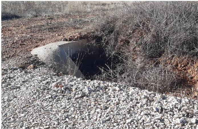
Fig. 3 Tubo de drenaje semitaponado con vegetación arbustiva en vial de acceso al aero MO2.02. Fuente: Elaboración propia
