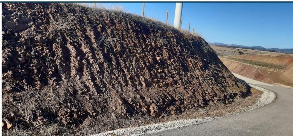
Fig. 1 Erosión hídrica en materiales lutíticos del talud de desmonte del vial de acceso al aero MO2.01. Fuente: Elaboración propia
