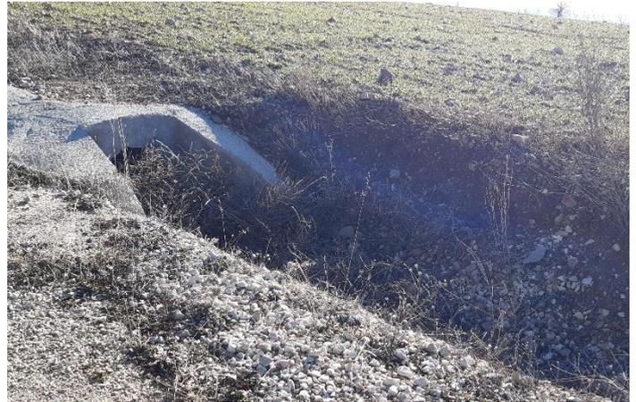
Fig. 2 Tubo de drenaje semitaponado con vegetación arbustiva en vial de acceso al aero MO2.05. Fuente: Elaboración propia
