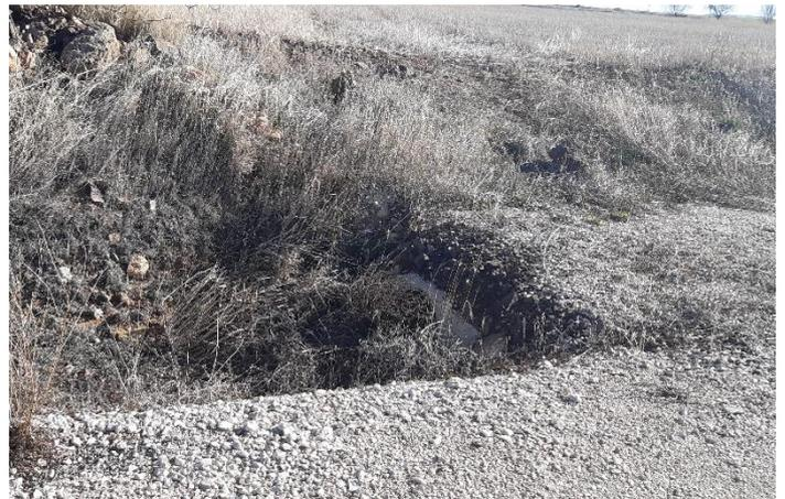
Fig. 4 Tubo de drenaje semitaponado con vegetación arbustiva en vial de acceso al aero MO2.01. Fuente: Elaboración propia
