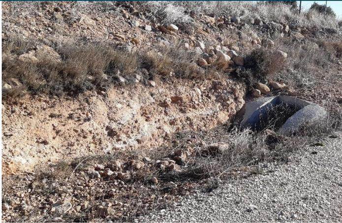
Fig. 1 Tubo de drenaje semitaponado con vegetación arbustiva en vial de acceso al aero MO2.06. Fuente: Elaboración propia
