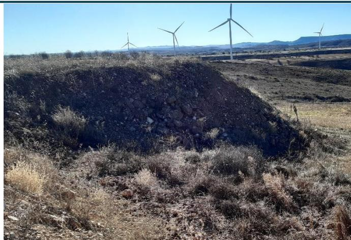
Fig. 2 Revegetación del talud de terraplén del aero MO2.05 en proceso.
