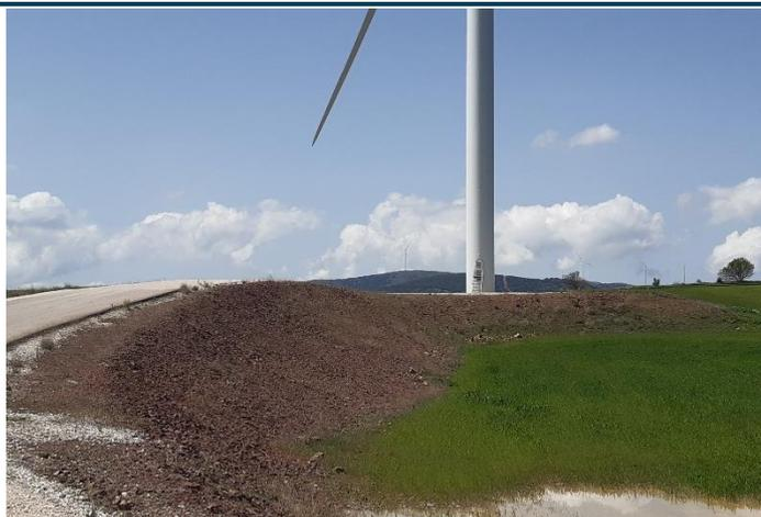
Fig. 1 Revegetación de talud terraplén del aero MO2.04 en proceso.
