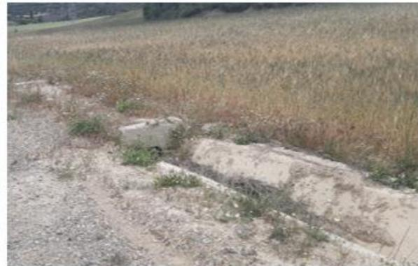
Fig. 2 Tubo de drenaje taponado por vegetación arbustiva y sedimentos en vial de acceso al aero LSA.01. Fuente: Elaboración propia
