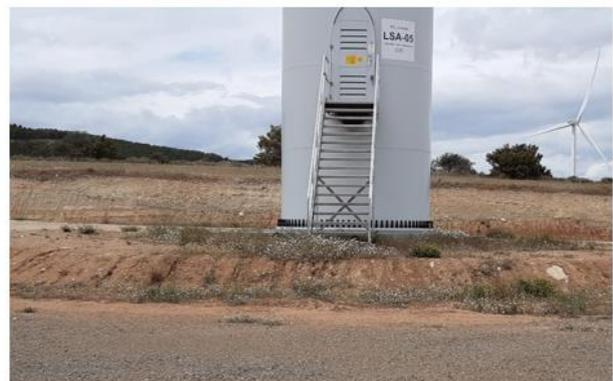
Fig. 3 Erosión hídrica en materiales lutíticos de la cimentación del aero LSA.05. Fuente: Elaboración propia
