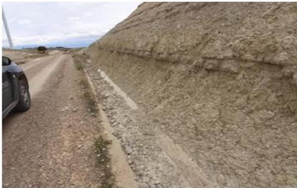
Fig. 1 Cuneta llena de sedimentos en vial de acceso al aero LSA.04.
