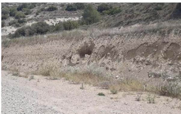
Fig. 2 Erosión hídrica en materiales margosos del talud de desmonte del vial de acceso al aero LSA.02. Fuente: Elaboración propia
