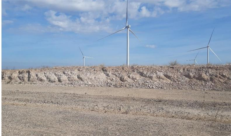
Fig. 1 Erosión hídrica en materiales arenosos del talud de desmonte del vial de acceso al aero MU1.04. Fuente: Elaboración propia
