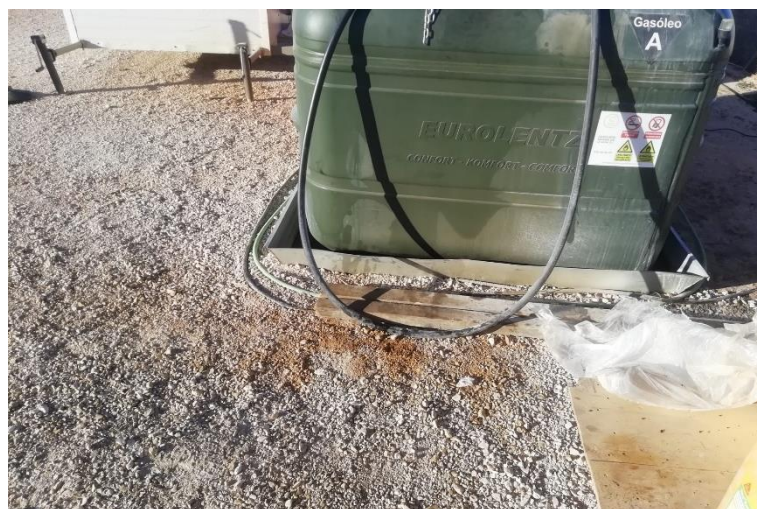
Foto 1 Mancha de gasolina en el suelo.
