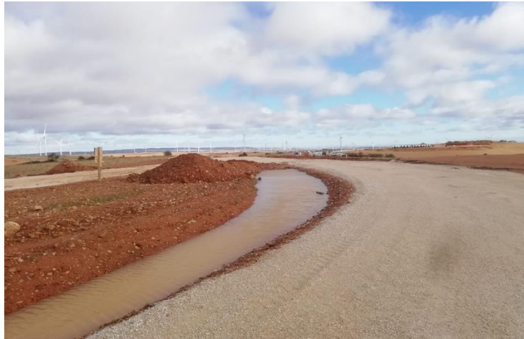
Foto 3 Agua de lluvias estancada.
