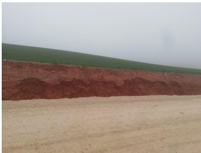
Foto 1 Talud erosionado.
