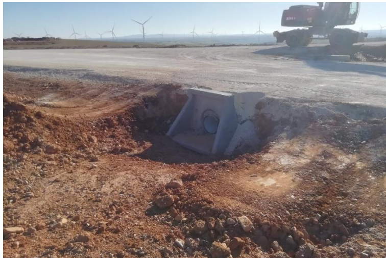
Foto 1 red de drenaje atravesando el vial.
