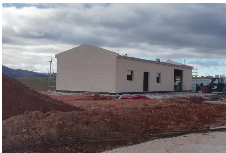
Foto 1 Edificio de control.
