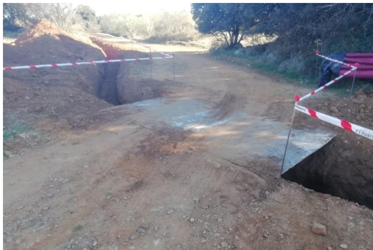
Foto 1 Zanja atravesando un camino existente.
