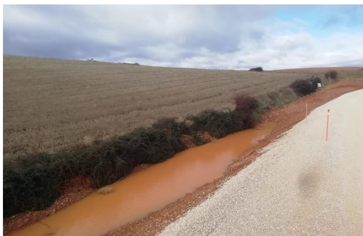
Foto 1 Agua de lluvias estancada.
