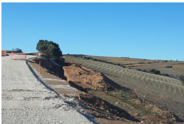
Foto 2 Zanja de media tensión y acopio de tierras.
