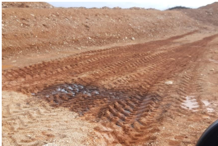
Foto 1 Derrame de betón en el acceso a la cimentación 4.
