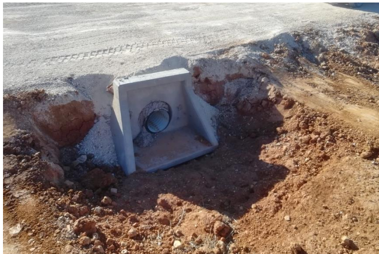
Foto 2 red de drenaje atravesando el vial.
