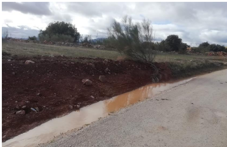
Foto 6 Agua de lluvias estancada.
