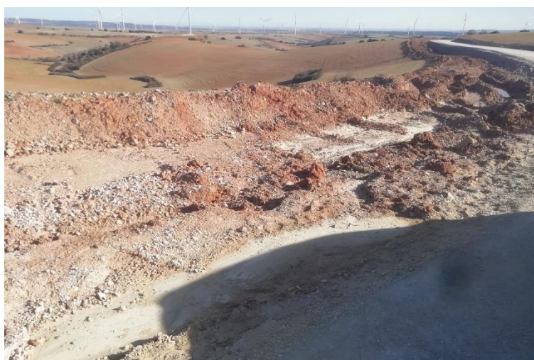
Foto 2 Zona del derrame limpi Restos de hormigón en la zona de lavado de WTG-05.
