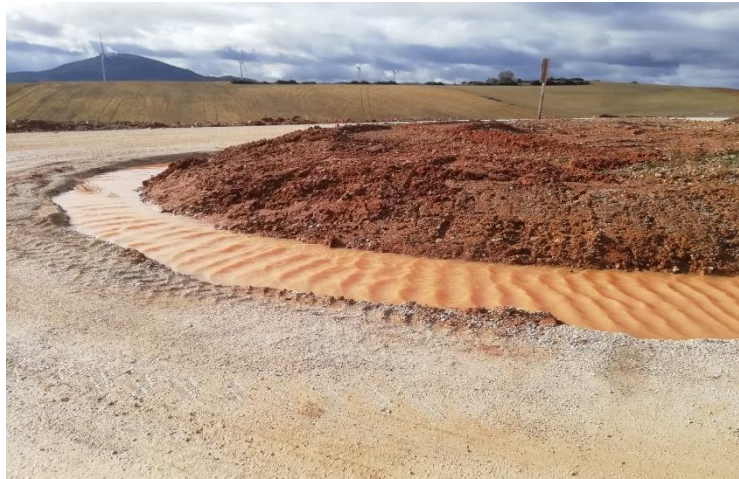
Foto 5 Agua de lluvias estancada.
