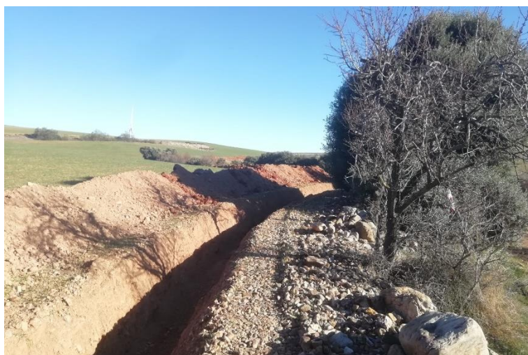
Foto 1 Zanja de media tensión y acopio de tierras.
