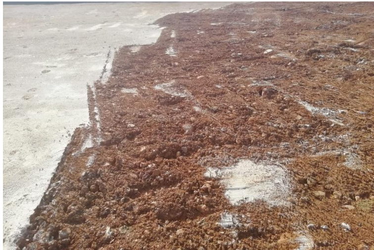
Foto 4: Restos de hormigón en la zona de lavado de WTG-06.
