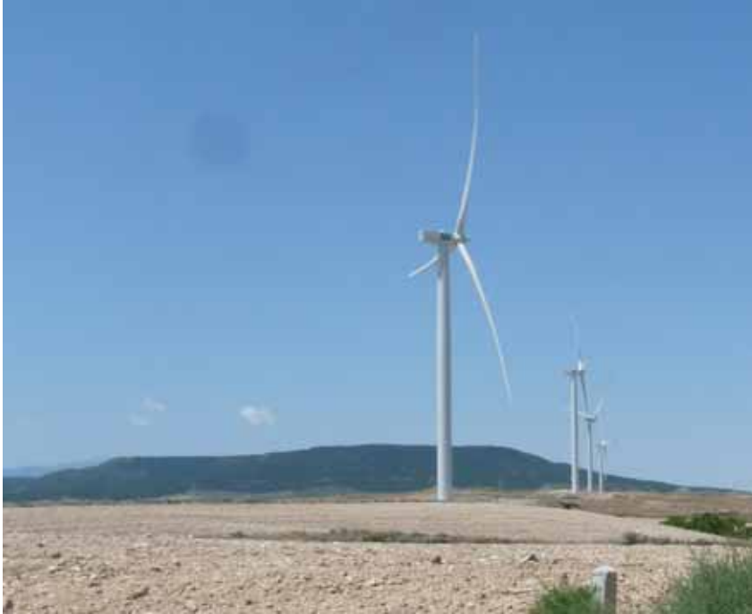
Aerogeneradores El Campo del 1 al 4 (primer plano)
