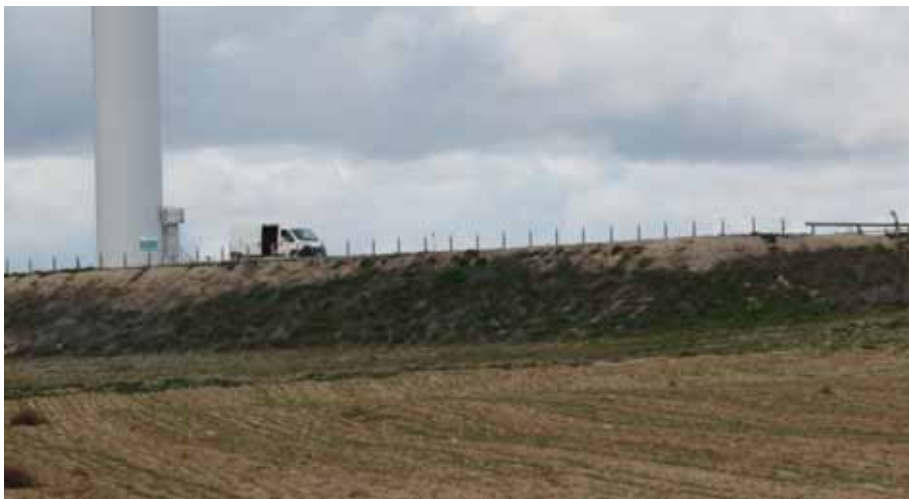
Foto 8. Evolución de la vegetación en los taludes de EC-02
