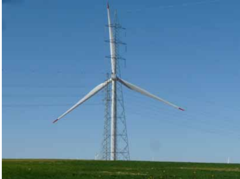
Foto 1. Infraestructuras eléctricas y aerogeneradores. Apoyo 42
