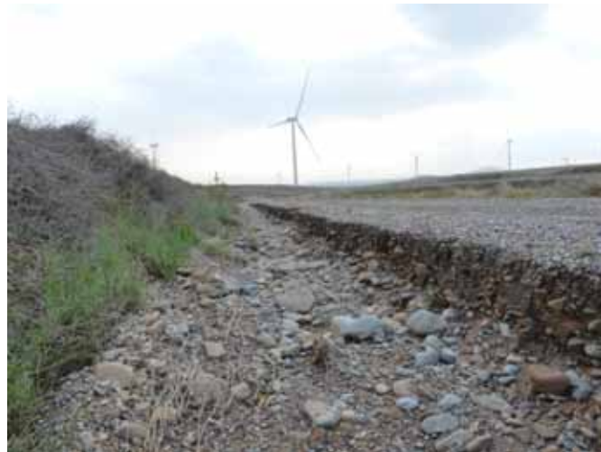
Foto 7. Ampliación de cuneta en vial de acceso
