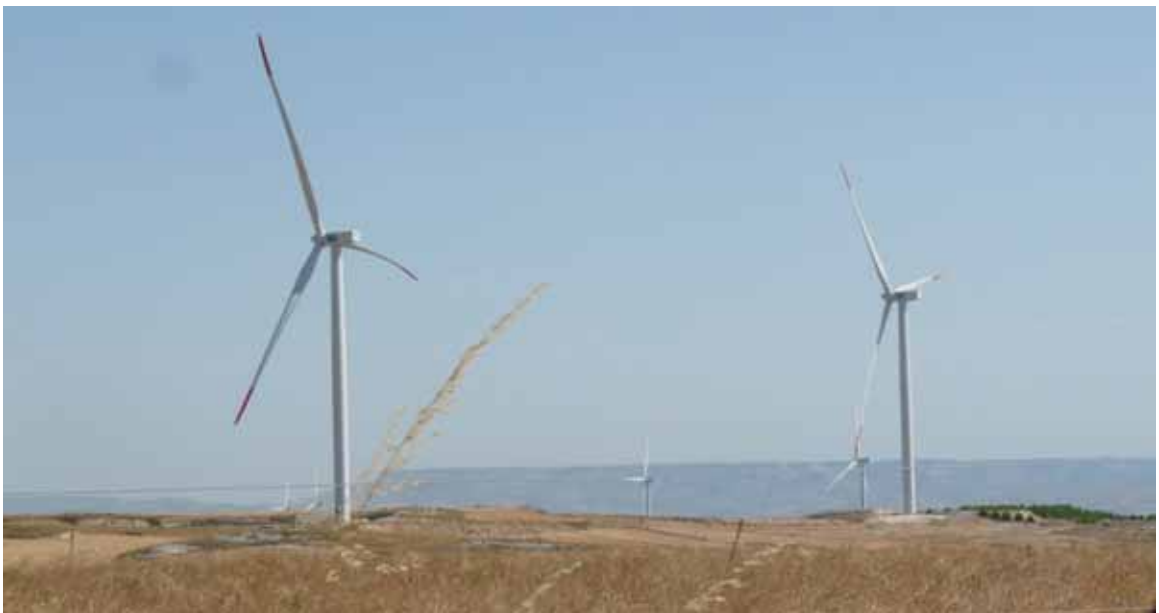
Visual de los aerogeneradores EC-05 y EC-06 desde el punto de observación MORTANDAD
