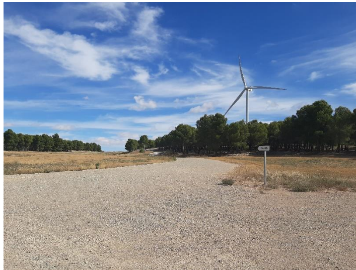
Vial de acceso al aerogenerador CAN-05
