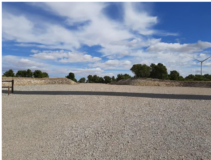
Plataforma del aerogenerador CAN-05
