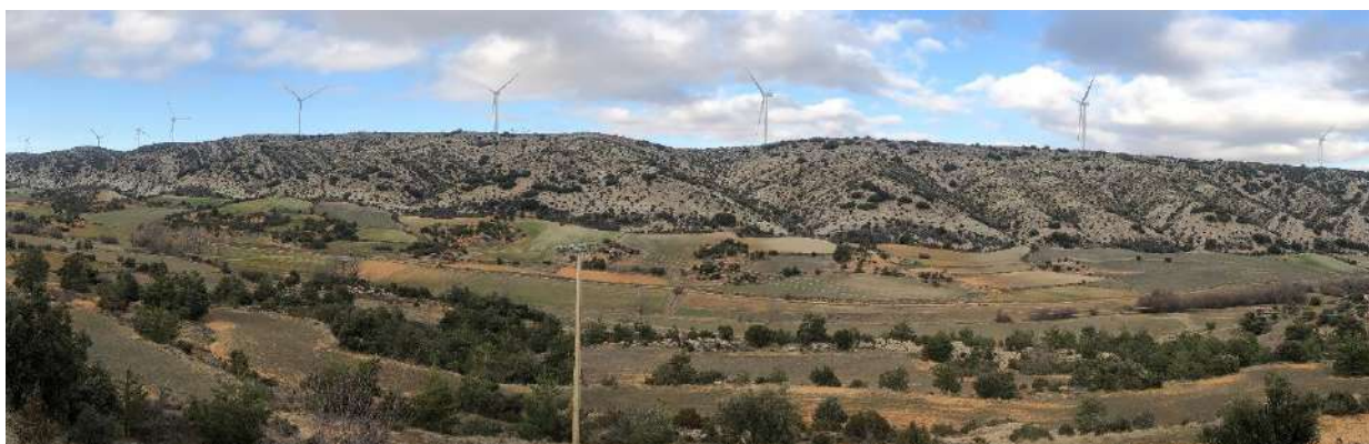
Figura 1: Foto panorámica del parque eólico Allueva
