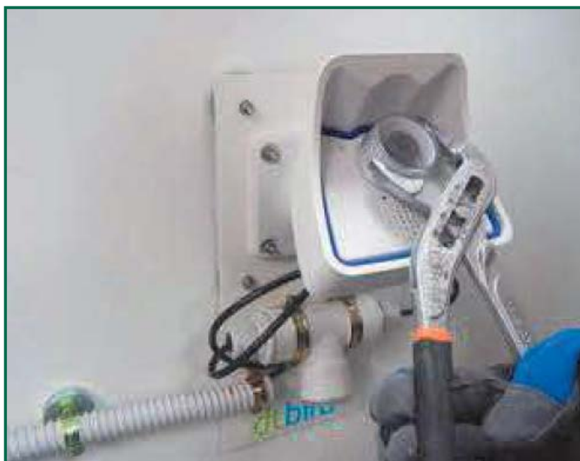
Fotografía 9. Cubrelente acoplado a la nueva cámara.
