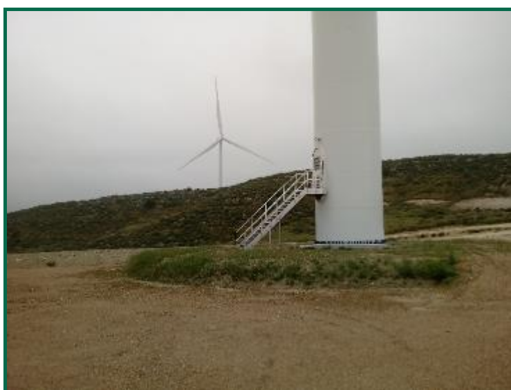
Fotografía 16. Talud de la plataforma, hidrosemebrado.
