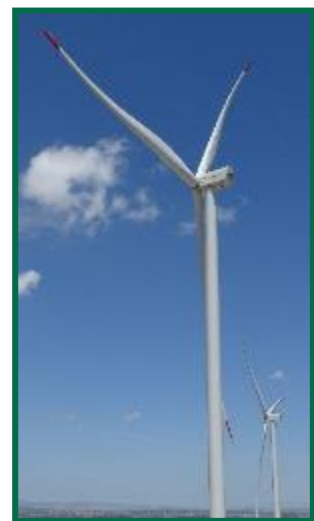
Fotografía 13. Pintado de palas en los aerogeneradores.
