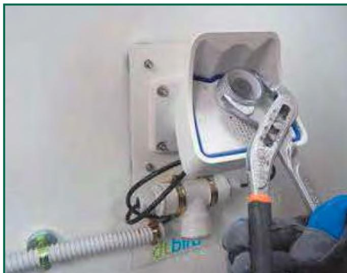
Fotografía 9. Cubrelente acoplado a la nueva cámara.
