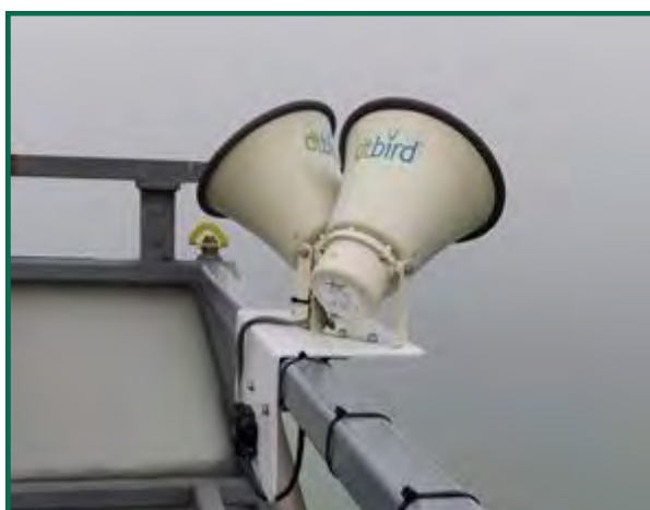
Fotografía 9. Sistema de anclaje de los altavoces.
