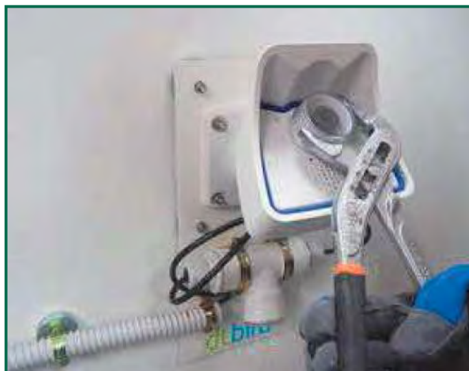
Fotografía 8. Cubrelente acoplado a la nueva cámara.
