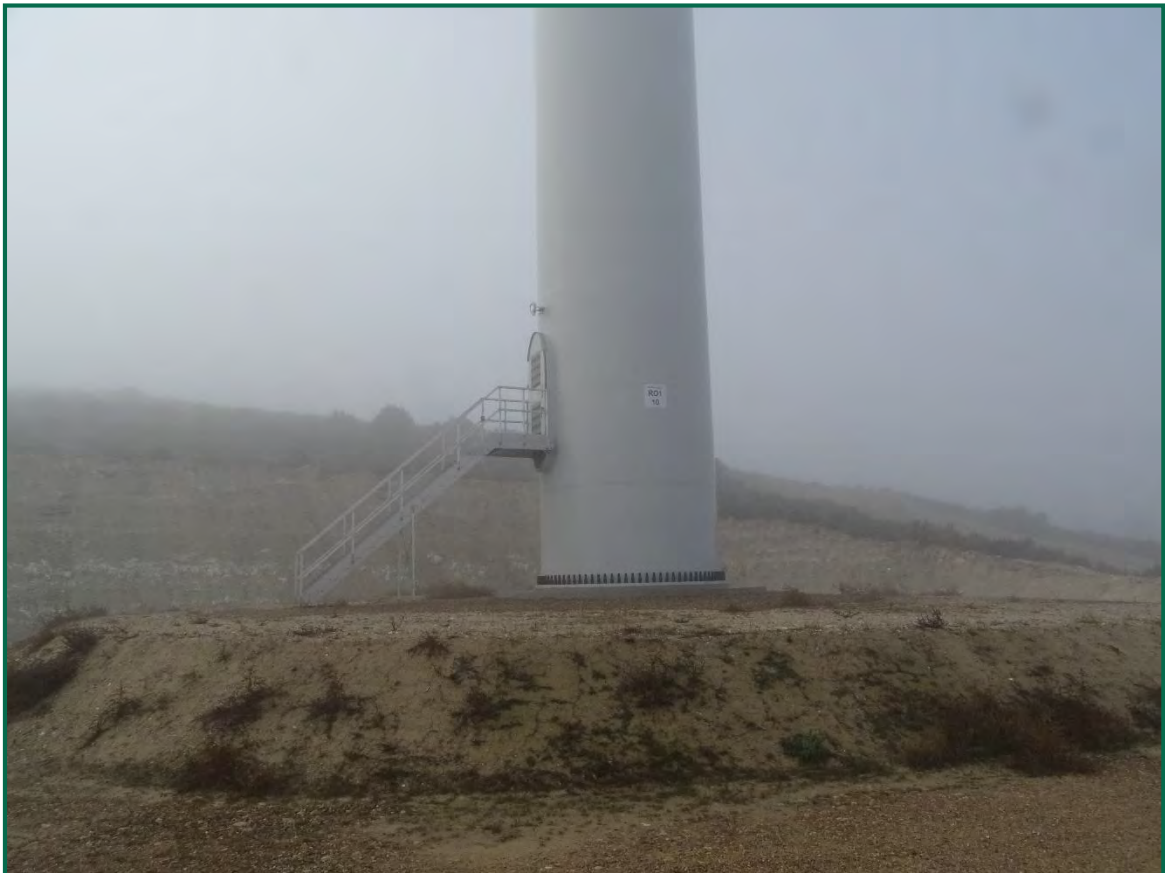
Fotografía 12. Resultado de la hidrosiembra en los flanes de las plataformas de los aerogeneradores.
