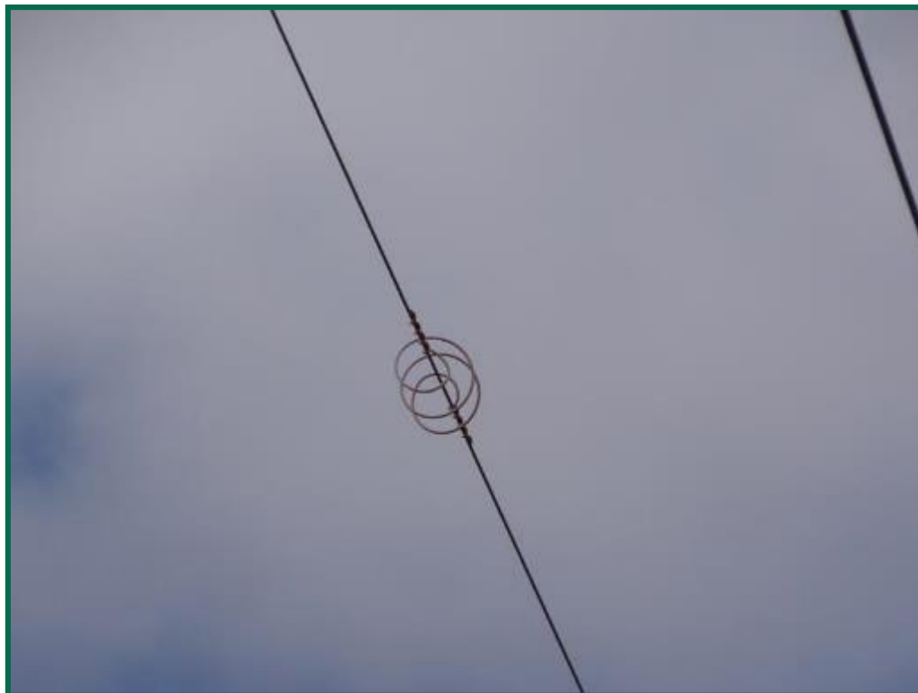
Fotografía 17. Detalle del sistema salvapájaros.
