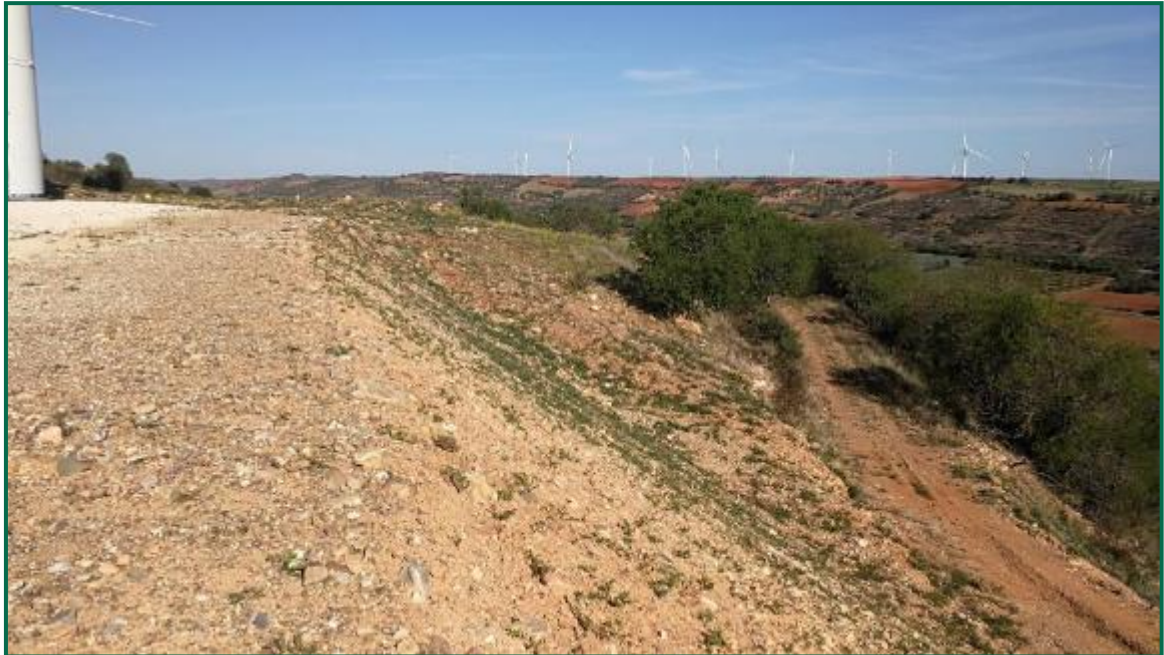
Fotografía 35. Talud en clúster Aguasvivas.
