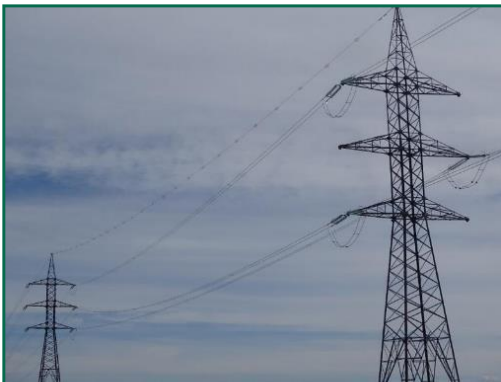
Fotografía 16. Apoyos de la LAAT de evacuación
