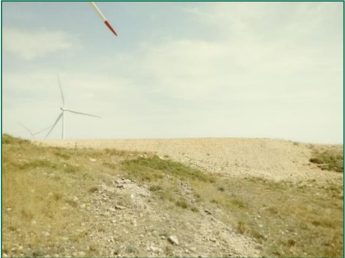
Fotografía 31. Talud en clúster Aguasvivas.
