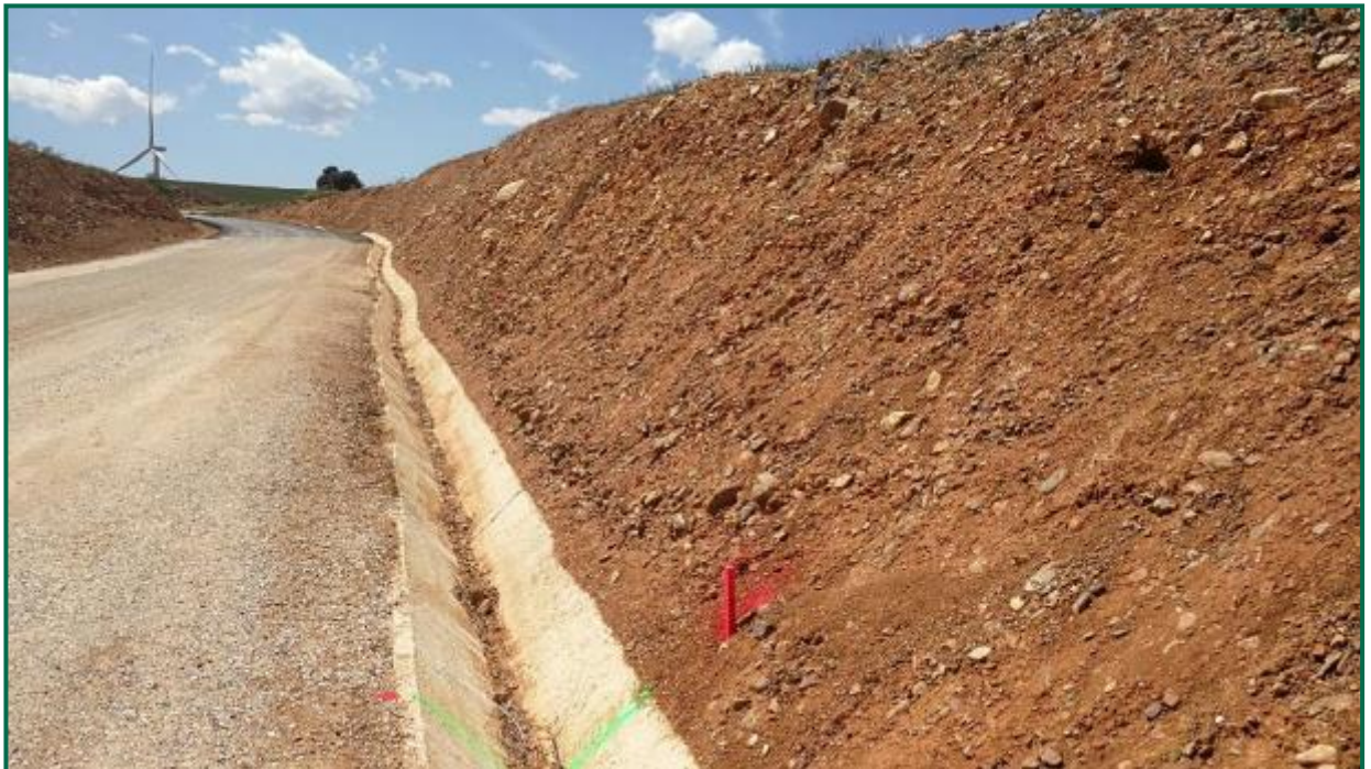
Fotografía 29. Talud en proceso de restauración y protección.
