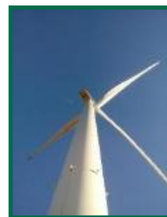
Fotografía 19. Sistemas de detección y disuasión instalado en aerogenerador.
