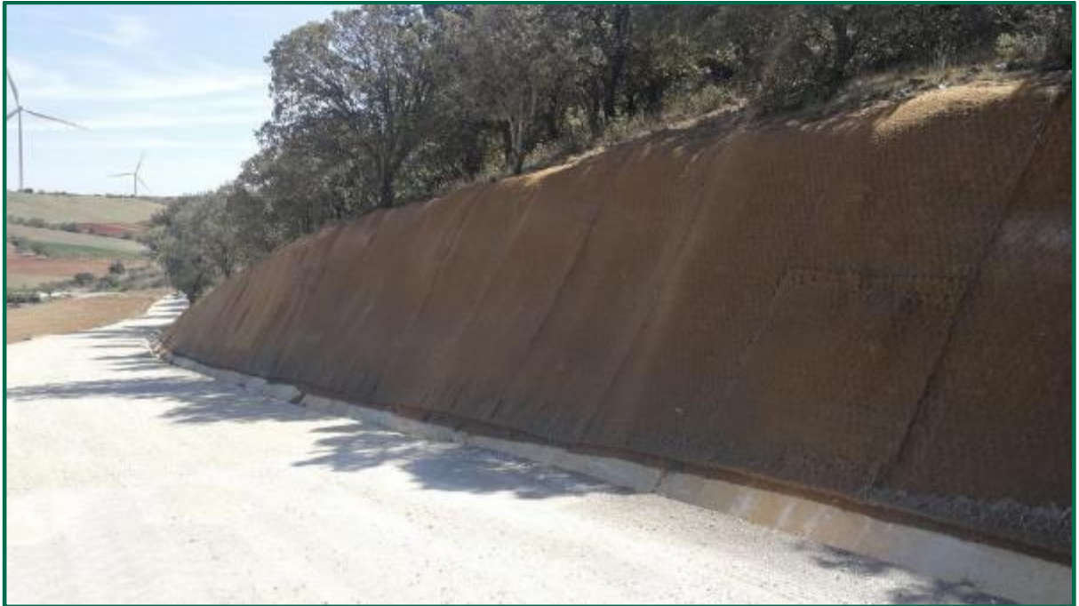
Fotografía 28. Fibra de coco y malla metálica en talud. (después)
