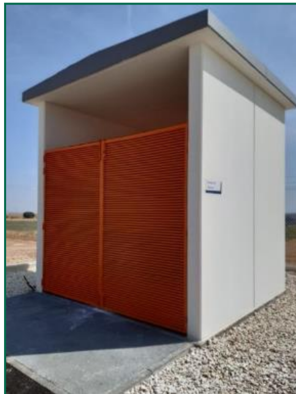
Fotografía 34. Almacén de residuos para gestor autorizado. Fuente: Repsol.
