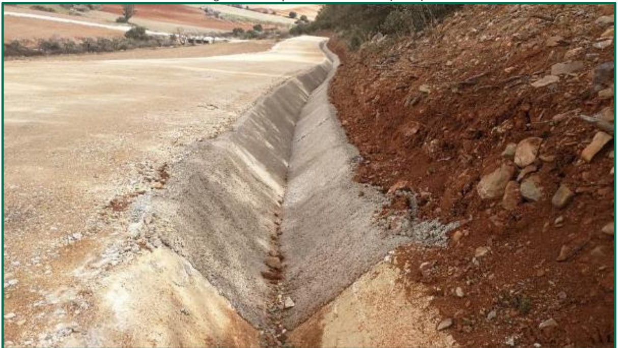
Fotografía 27. Tramo de cuneta hormigonado. (después)
