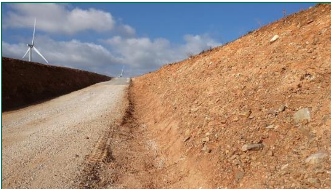
Fotografía 25. Limpieza de las cunetas.
