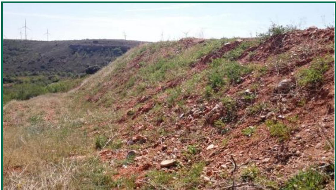
Fotografía 33. Talud en el clúster Aguasvivas.
