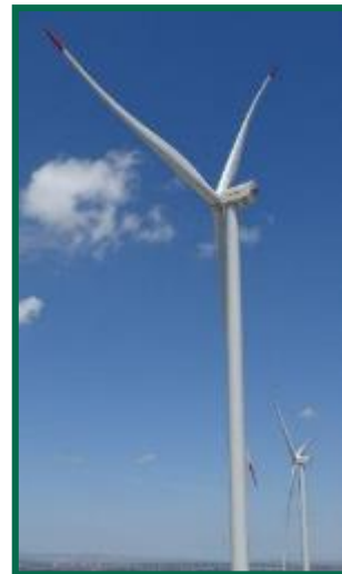
Fotografía 18. Pintado de palas en los aerogeneradores.
