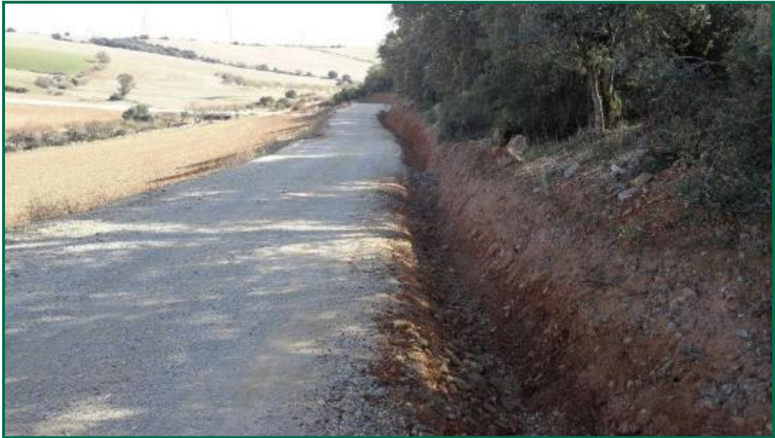
Fotografía 26. Limpieza de las cunetas. (antes)
