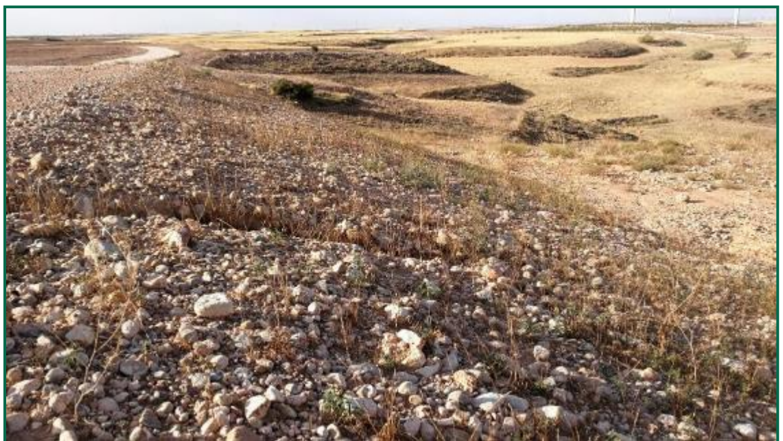
Fotografía 32. Talud en clúster Aguasvivas, aspecto actual.
