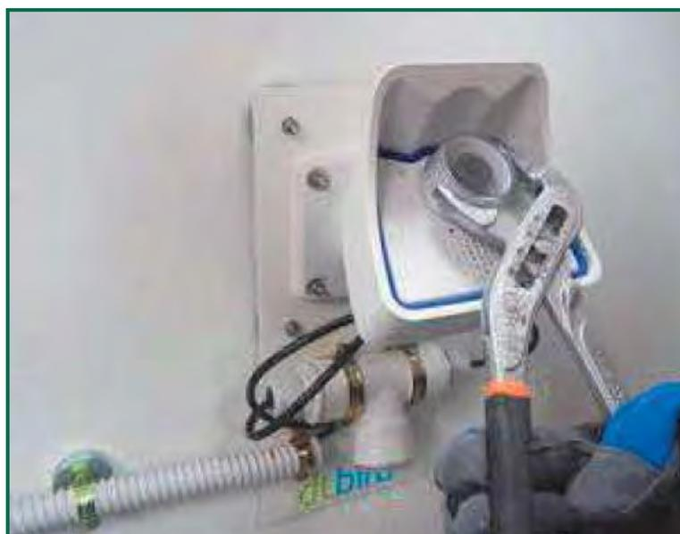
Fotografía 25. Cubrelente acoplado a la nueva cámara.
