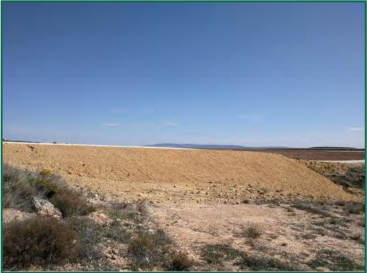
Fotografía 31. Talud en LM7D-05 con hidrosiembra.
