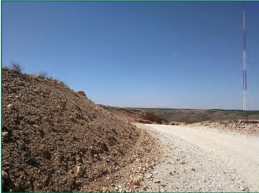
Fotografía 32. Talud pista torre meteorológica LM7D con hidrosiembra.
