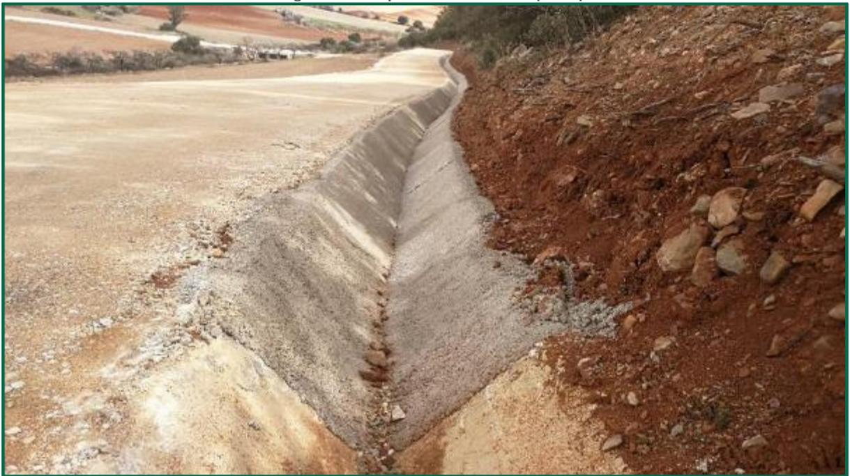
Fotografía 27. Tramo de cuneta hormigonado. (después)
