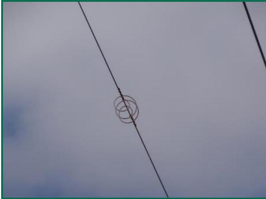
Fotografía 15. Detalle del sistema anti pájaros de la LAAT de evacuación.
