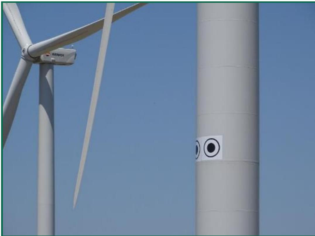
Fotografía 22. “Looming eyes” instalados en uno de los parques de Repsol en Aragón.
