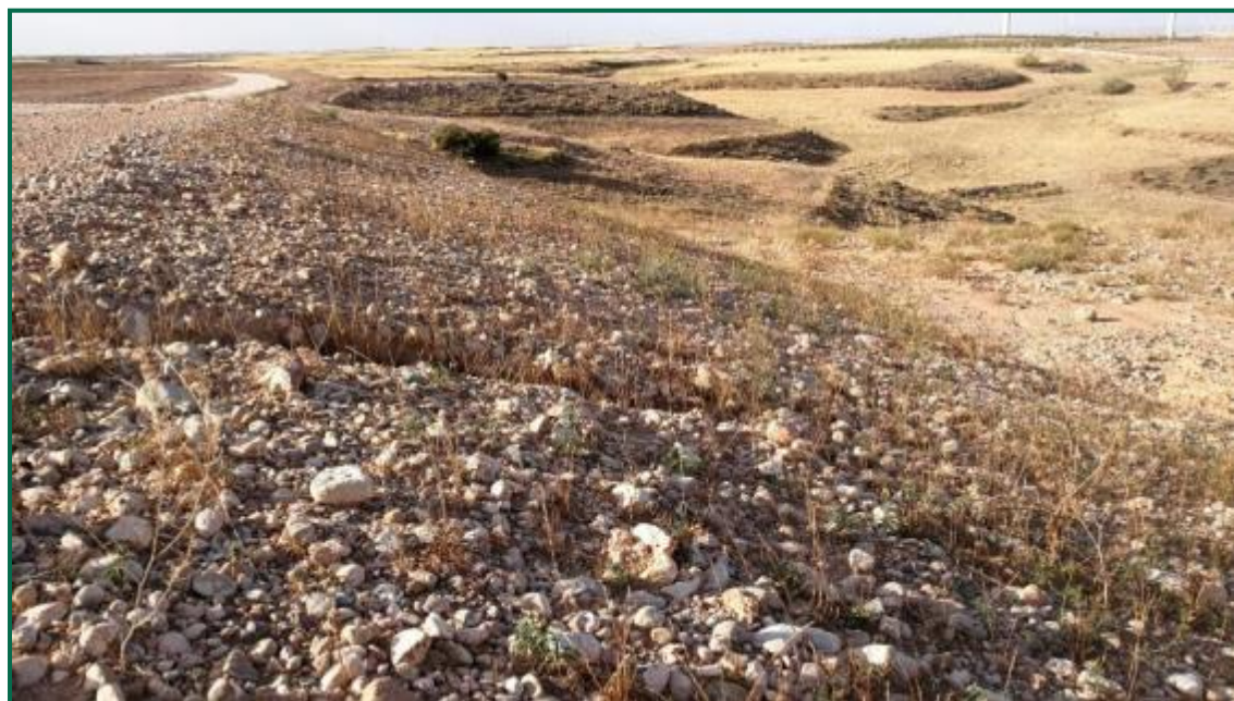
Fotografía 28. Talud en clúster Aguasvivas, aspecto actual.
