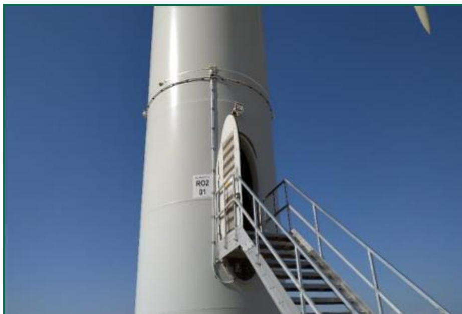
Fotografía 18.. Nuevo sistema W4-D10, instalado en ROII-01.
