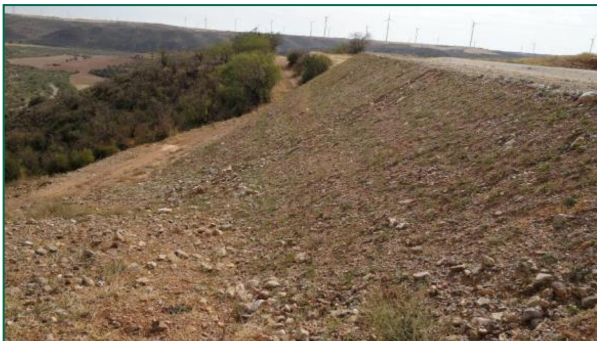
Fotografía 32. Talud en clúster Aguasvivas. Aspecto actual.
