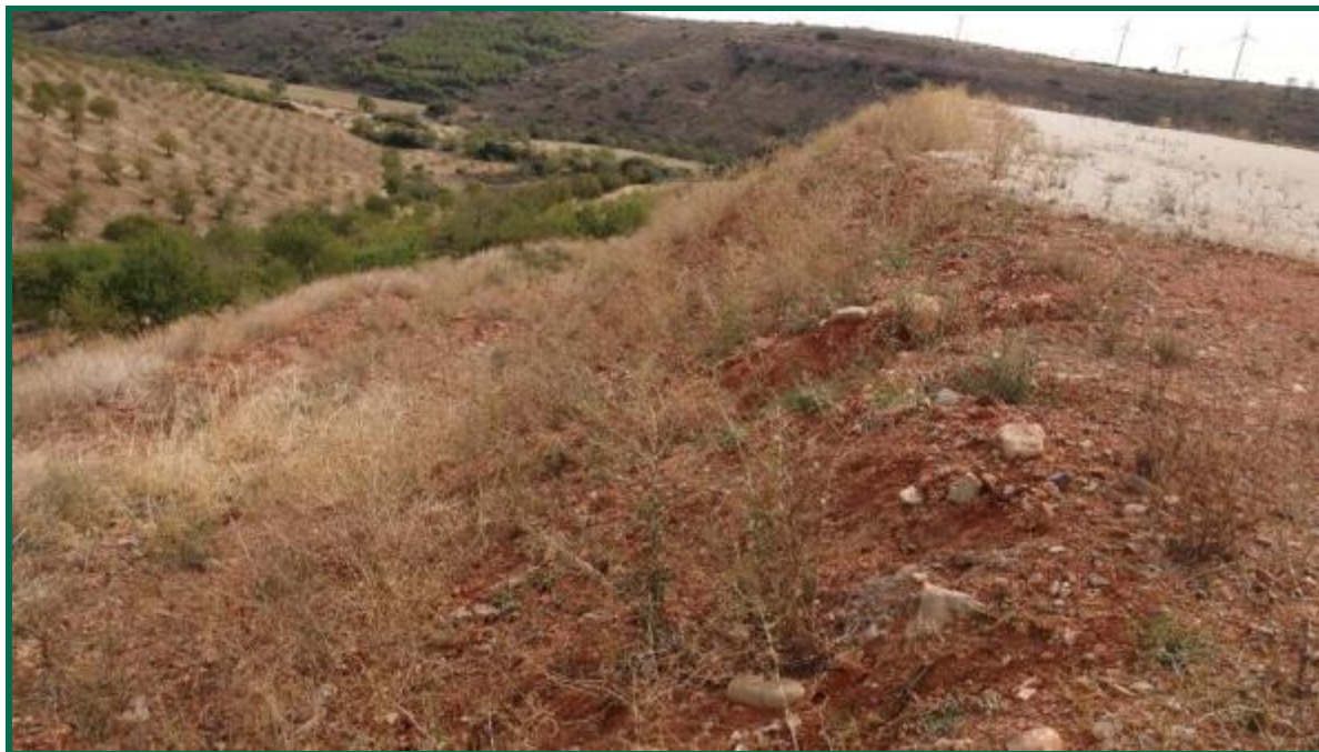
Fotografía 30. Talud en el clúster Aguasvivas, actualmente.
