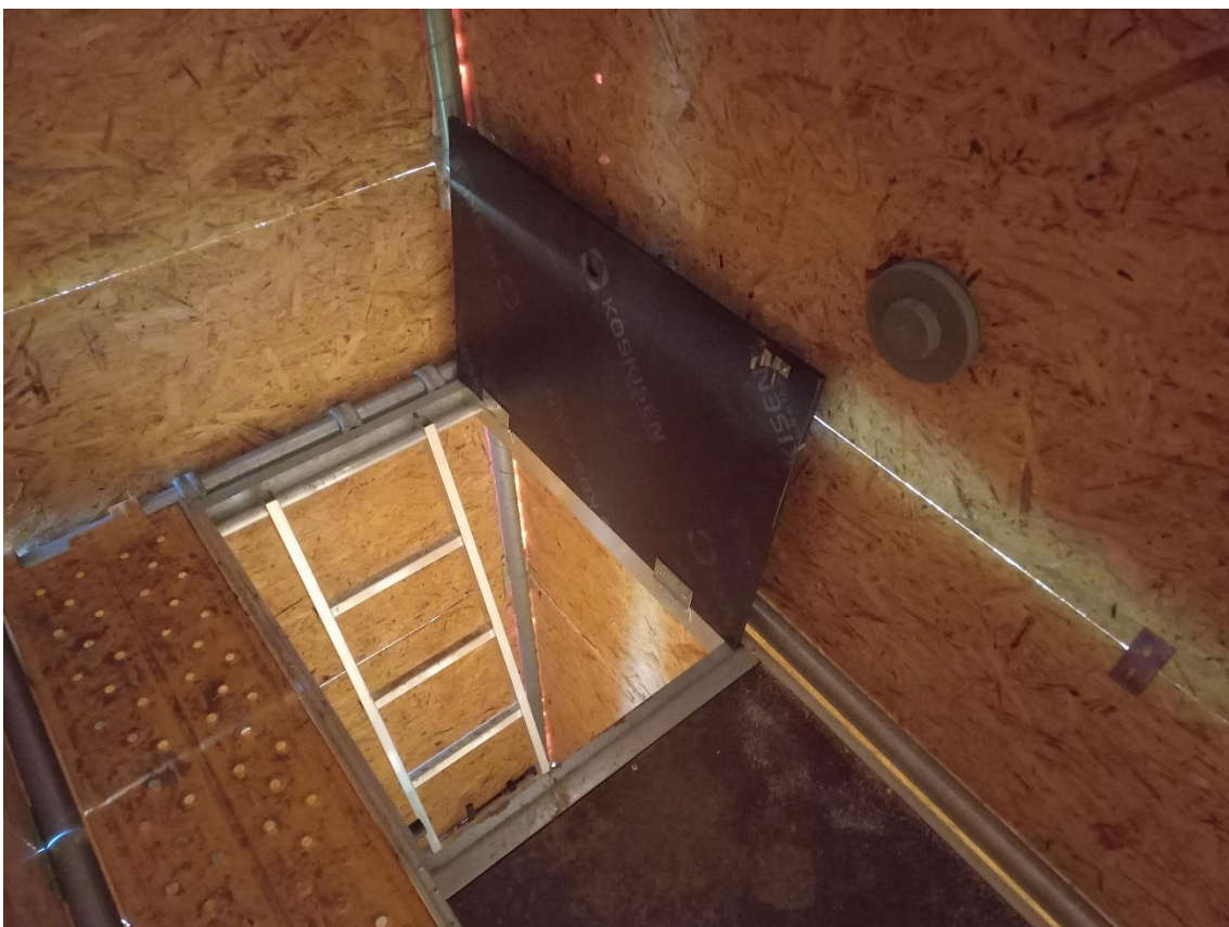
Foto nº 8. Jaula - hacking, detalle de la escalera del habitáculo y el tapón de un tubo comedero.
