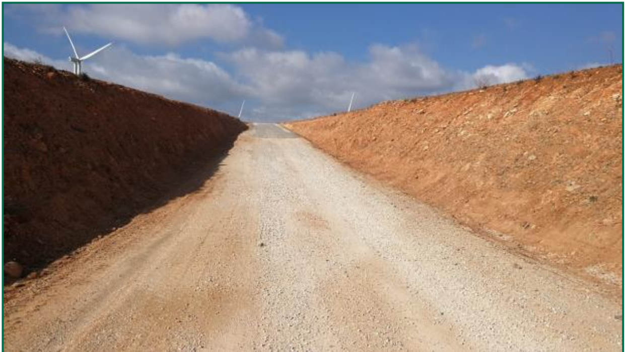
Fotografía 24. Limpieza de las cunetas.
