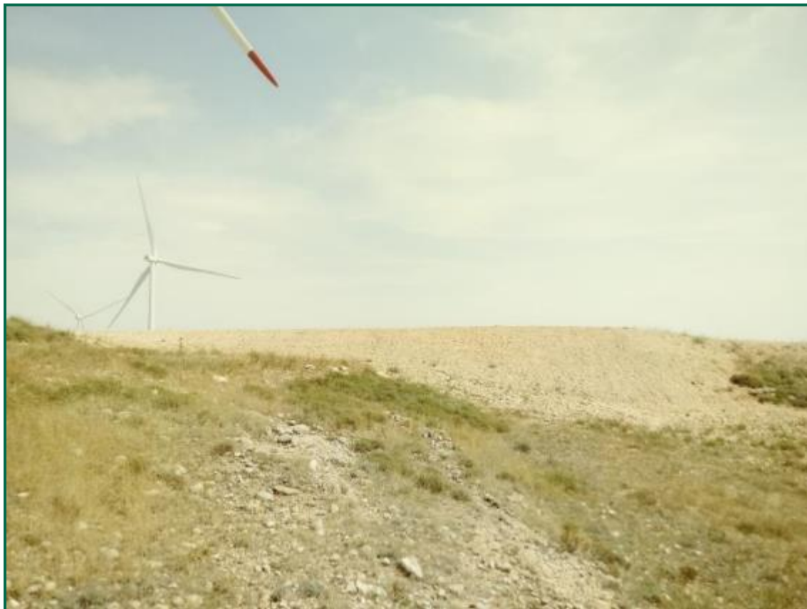
Fotografía 27. Talud en clúster Aguasvivas.
