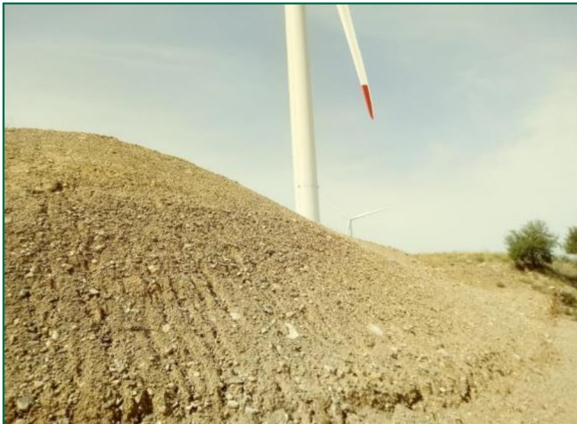
Fotografía 31. Talud en clúster Aguasvivas.
