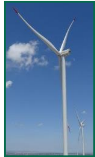
Fotografía 16. Pintado de palas en los aerogeneradores.
