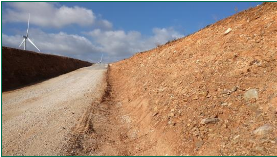
Fotografía 25. Limpieza de las cunetas.
