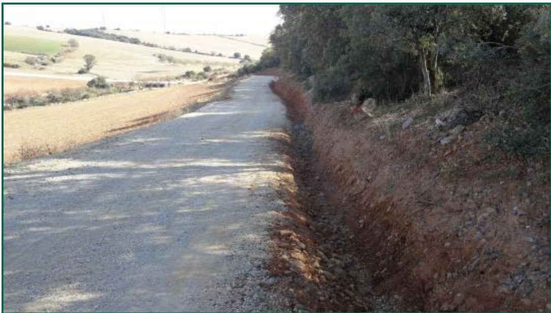
Fotografía 26. Limpieza de las cunetas.
