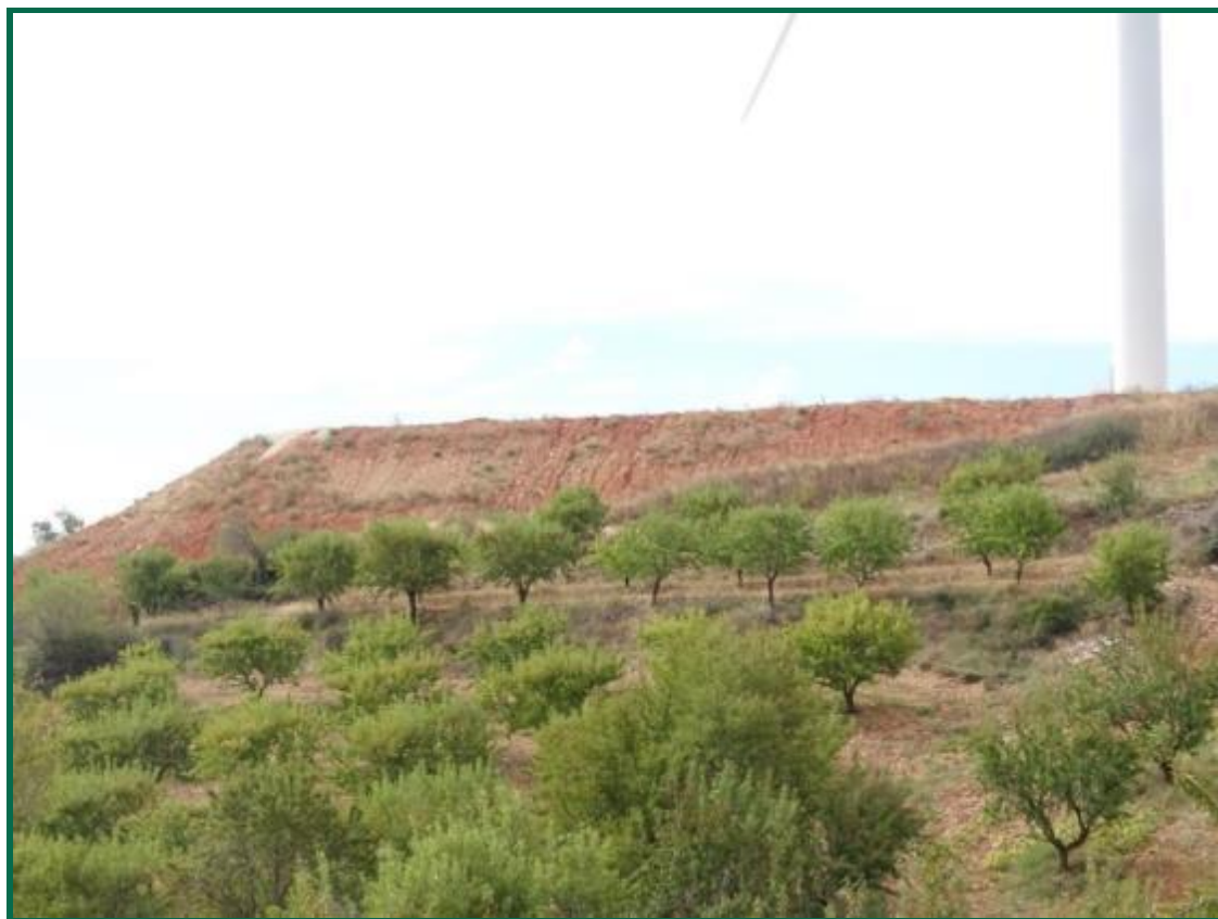
Fotografía 29. Talud en el clúster Aguasvivas.
