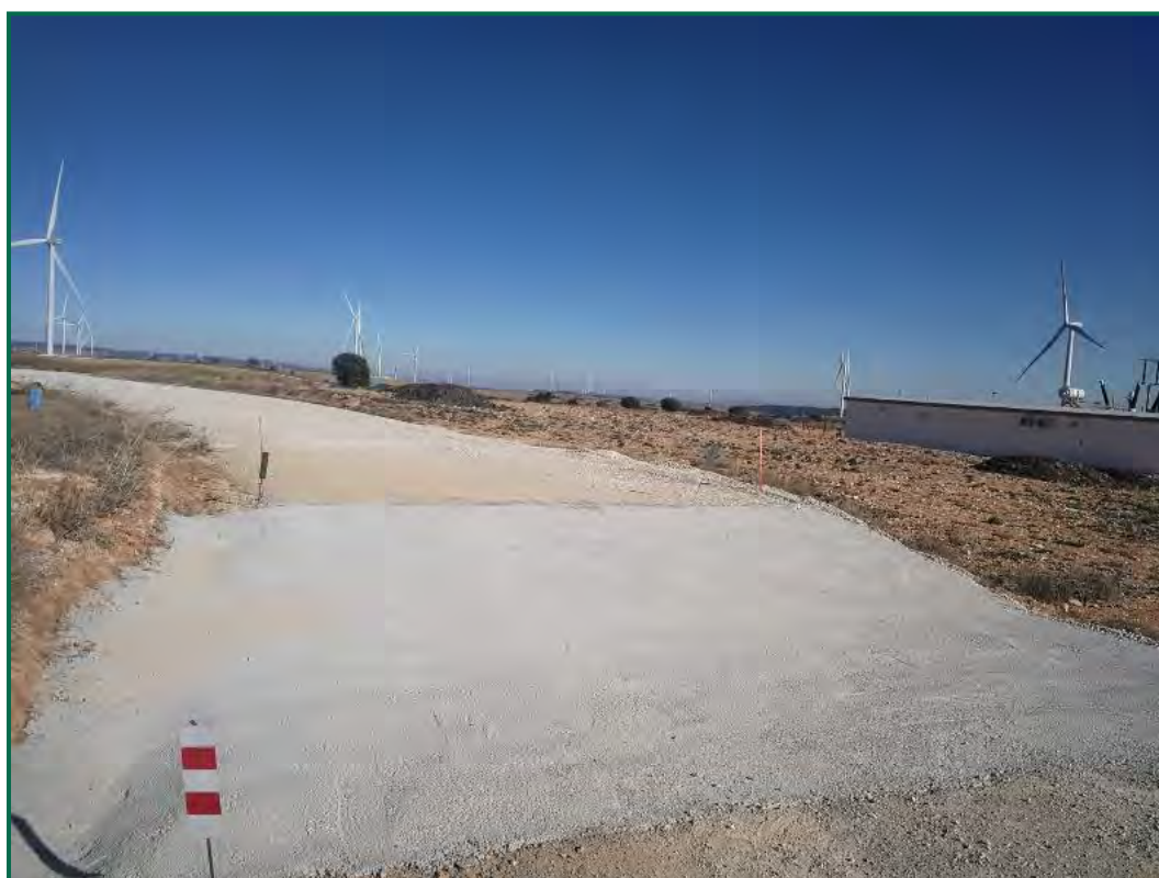
Fotografía 8. Hormigonado de badén.
