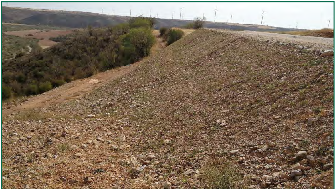
Fotografía 15. Talud en clúster Aguasvivas. Aspecto actual.
