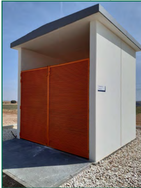
Fotografía 16. Almacén de residuos para gestor autorizado. Fuente: Repsol.
