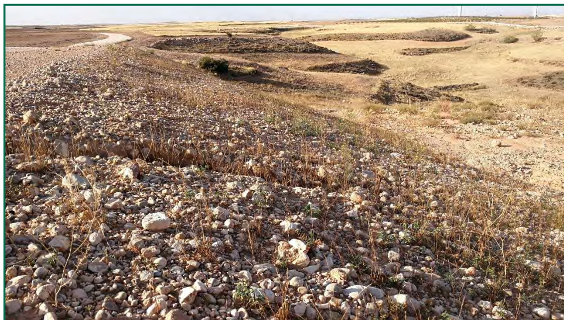
Fotografía 11. Talud en clúster Aguasvivas, aspecto actual.
