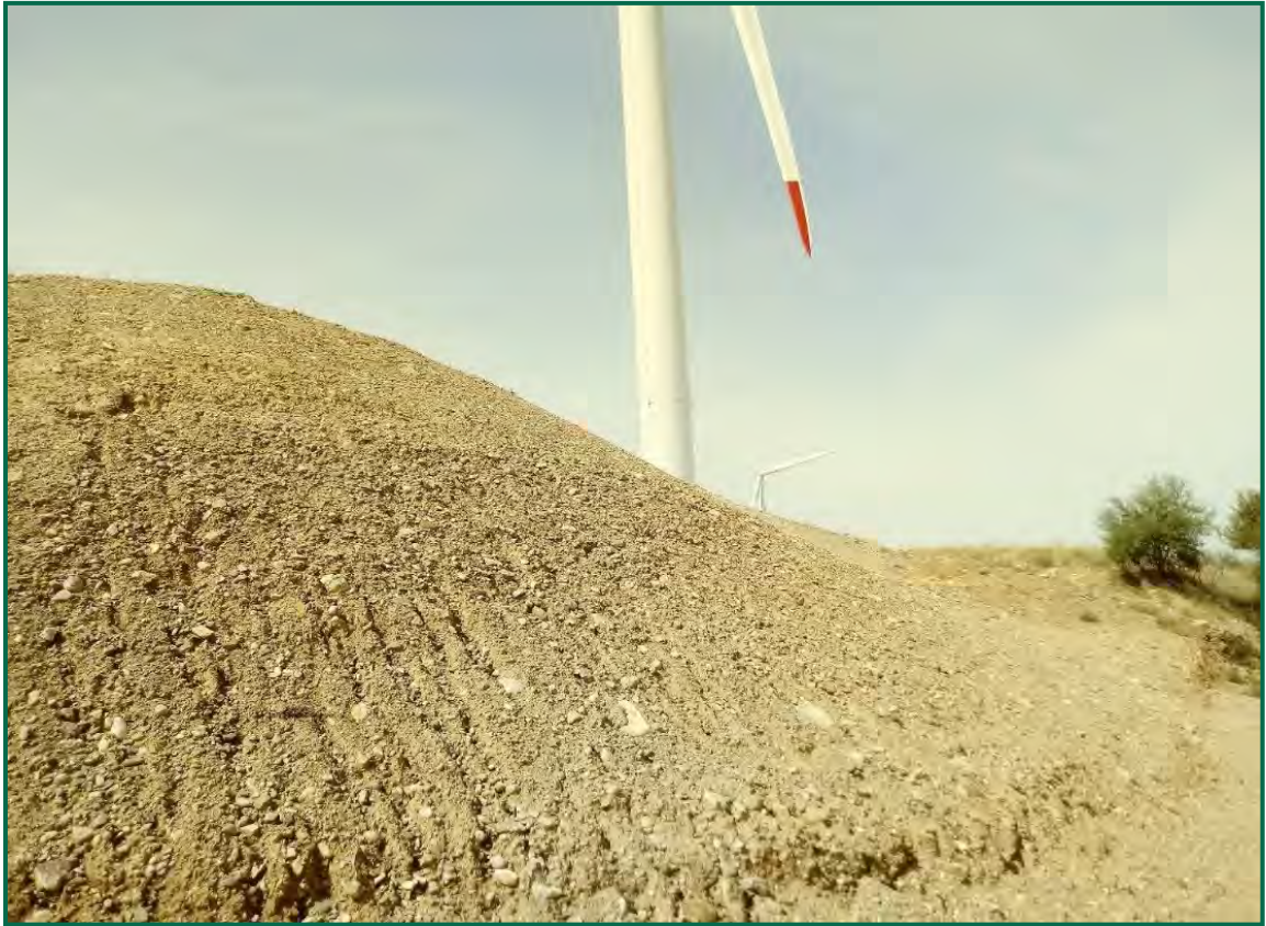
Fotografía 14. Talud en clúster Aguasvivas.
