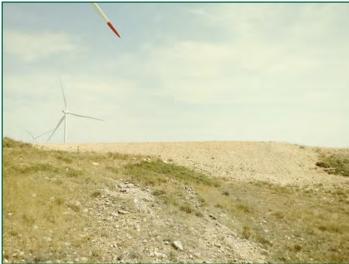
Fotografía 10. Talud en clúster Aguasvivas.
