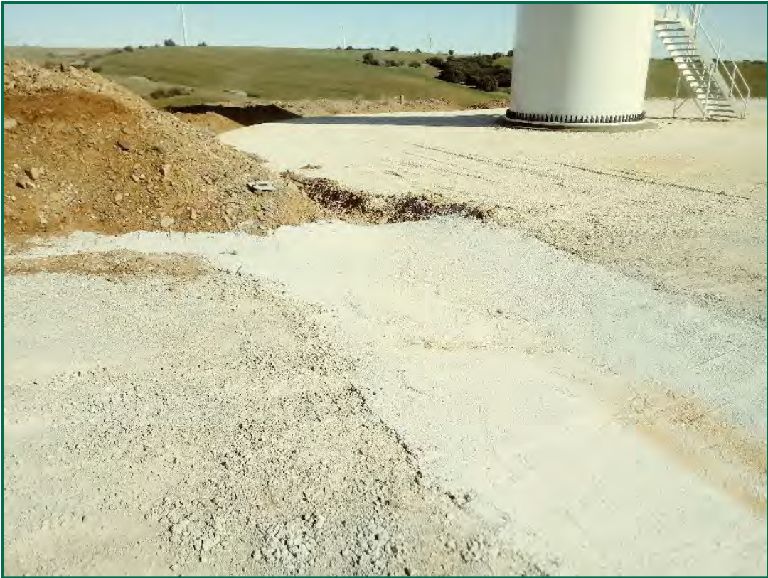
Fotografía 9. Hormigonado de badén.
