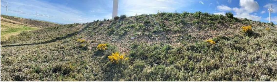
Foto nº35.: T-14: Plantación en el talud en terraplén de la plataforma.
