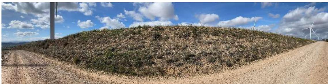
Foto nº33.: T-13: Hidrosiembra sobre talud en desmonte junto al camino de acceso.
