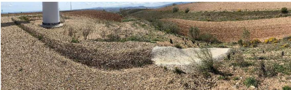
Foto nº38.: T-06: Canalización de agua para evitar escorrentías por el talud.
