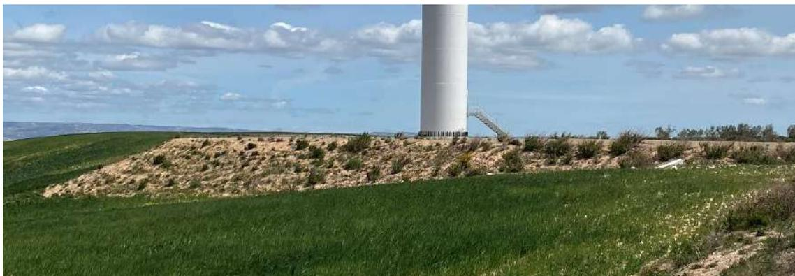
Foto nº31.: T-12: Plantación en el talud en terraplén de la plataforma.
