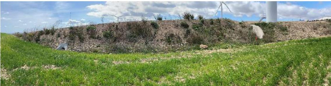
**Foto nº28.:** T-07: Plantación en el talud en terraplén de la plataforma.
