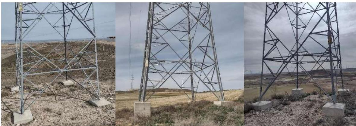
Foto nº21.: Estado general de los apoyos. Ejemplo del Apoyo nº 14, Apoyo nº 17 y Apoyo nº 18 de la LAAT.
