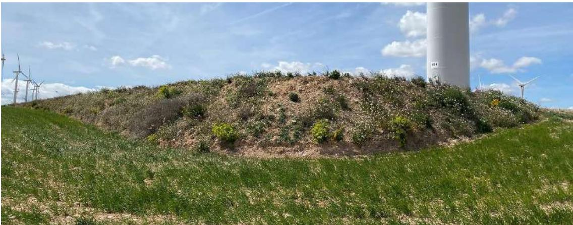
Foto nº25.: T-04: Plantación en el talud en terraplén de la plataforma.
