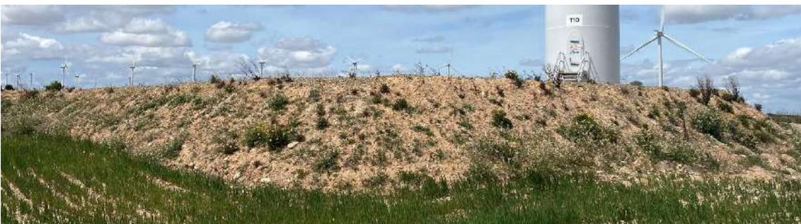
**Foto nº30.:** T-10: Hidrosiembra en el talud en terraplén de la plataforma.
