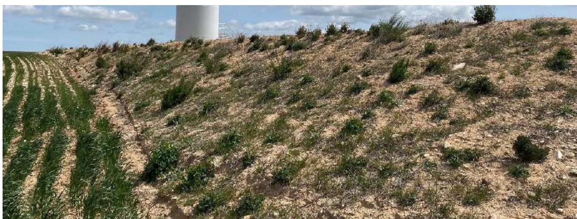
Foto nº32.: T-12: Plantación en el talud en terraplén de la plataforma.
