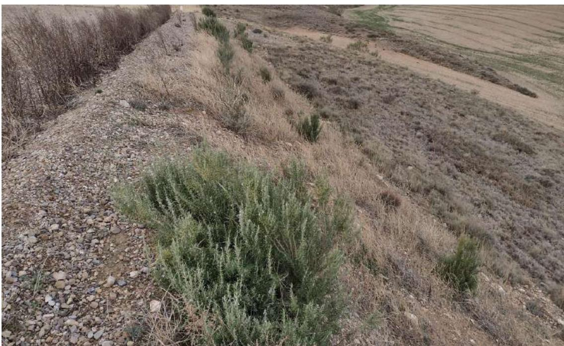
**Foto nº35.:** T-14: Plantación en el talud en terraplén de la plataforma.
