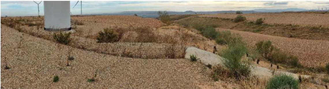
Foto nº37.: T-06: Canalización de agua para evitar escorrentías por el talud.
