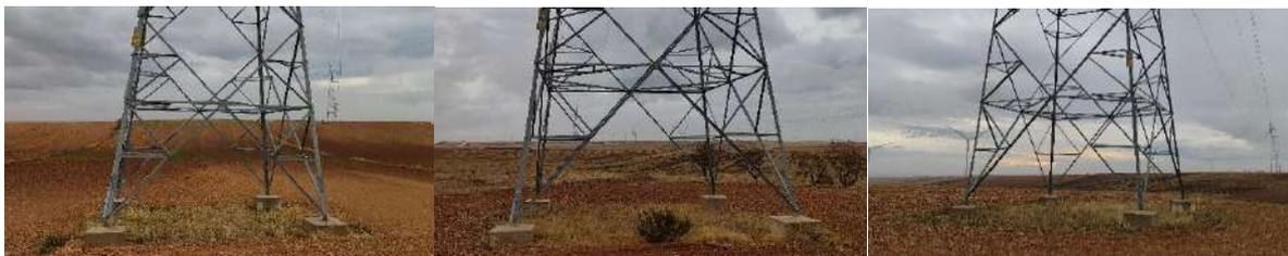
**Foto nº18.:** Estado general de los apoyos. Ejemplo del Apoyo nº 7, Apoyo nº 9 y Apoyo nº 10 de la LAAT.
