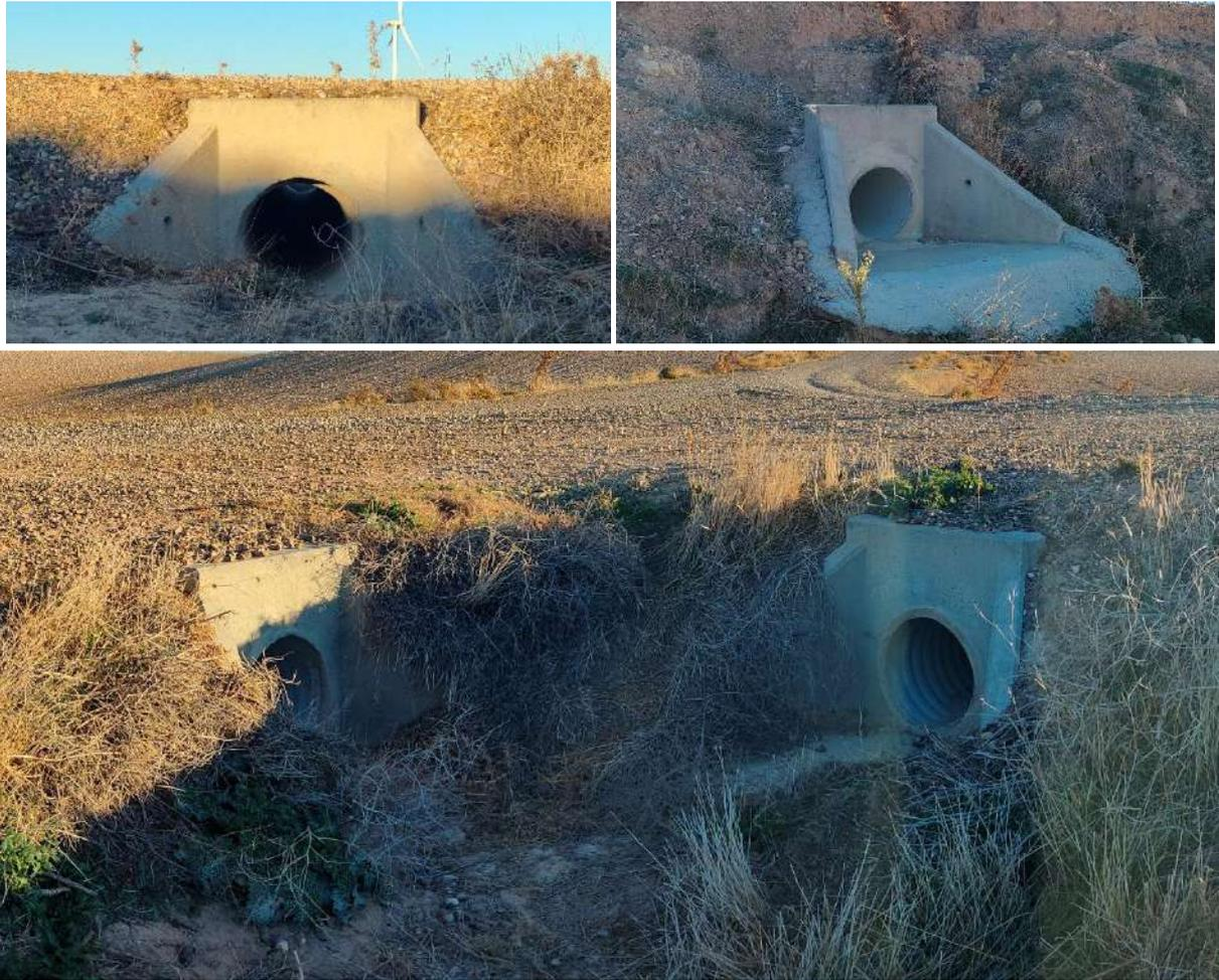
**Foto nº44.:** Detalle: Drenaje de vial de acceso PE.
