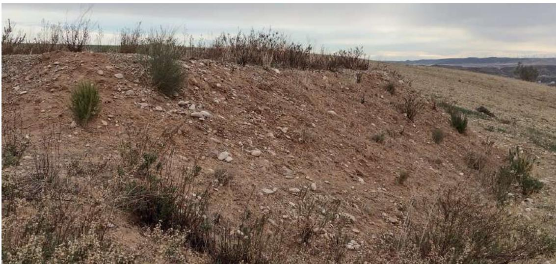
**Foto nº31.:** T-12: Plantación en el talud en terraplén de la plataforma.
