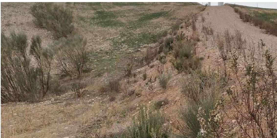
**Foto nº32.:** T-12: Plantación en el talud en terraplén del camino de acceso.
