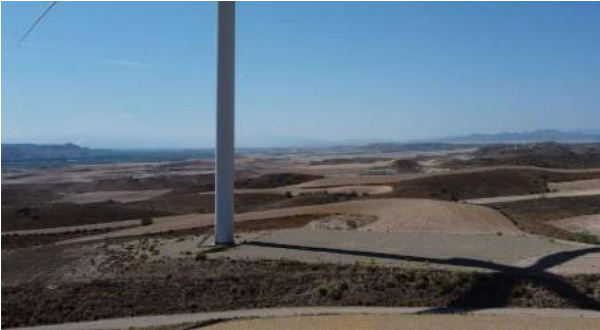
Foto nº13.: Plataforma del Aerogenerador T-13.
