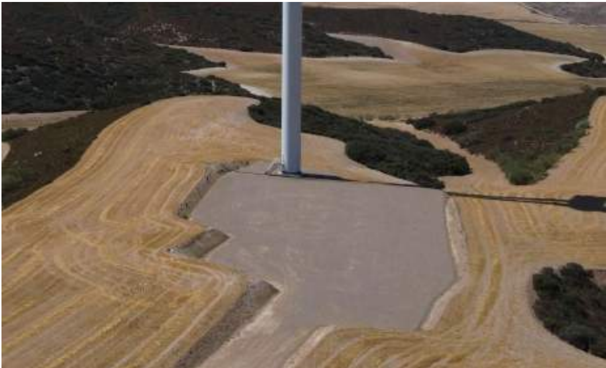
Foto nº2.: Plataforma del Aerogenerador T-02.
