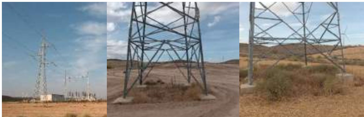
Foto nº15.: Estado general de los apoyos. Ejemplo del Apoyo nº 1 y nº 2 de la LAAT.
