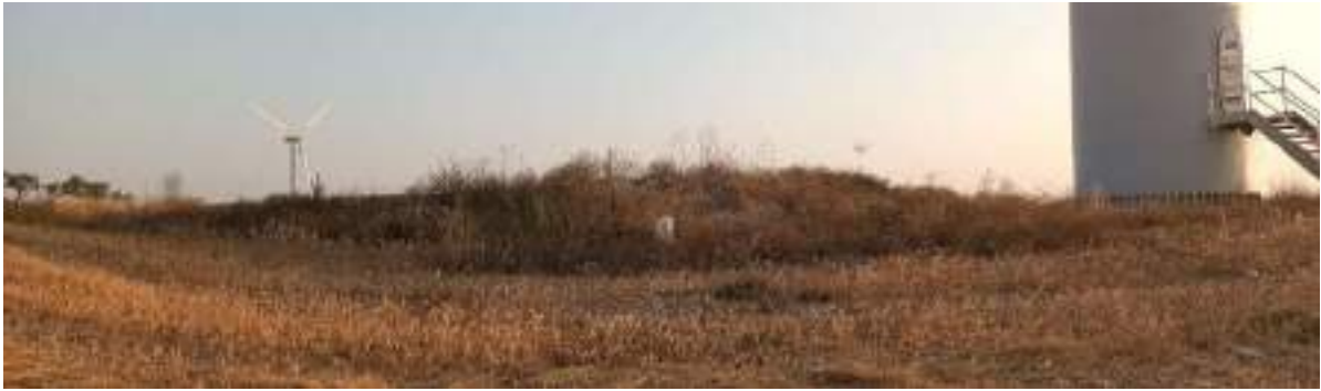
Foto nº23.: T-05: Colonización de vegetación natural en el talud del terraplén de la plataforma.
