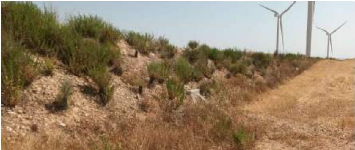
Foto nº25.: T-07: Plantación en el talud en terraplén del camino.
