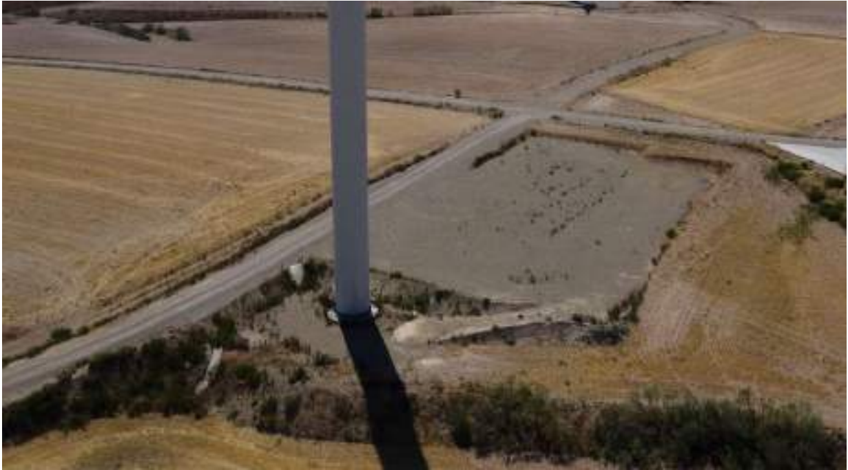
Foto nº7.: Plataforma del Aerogenerador T-07.
