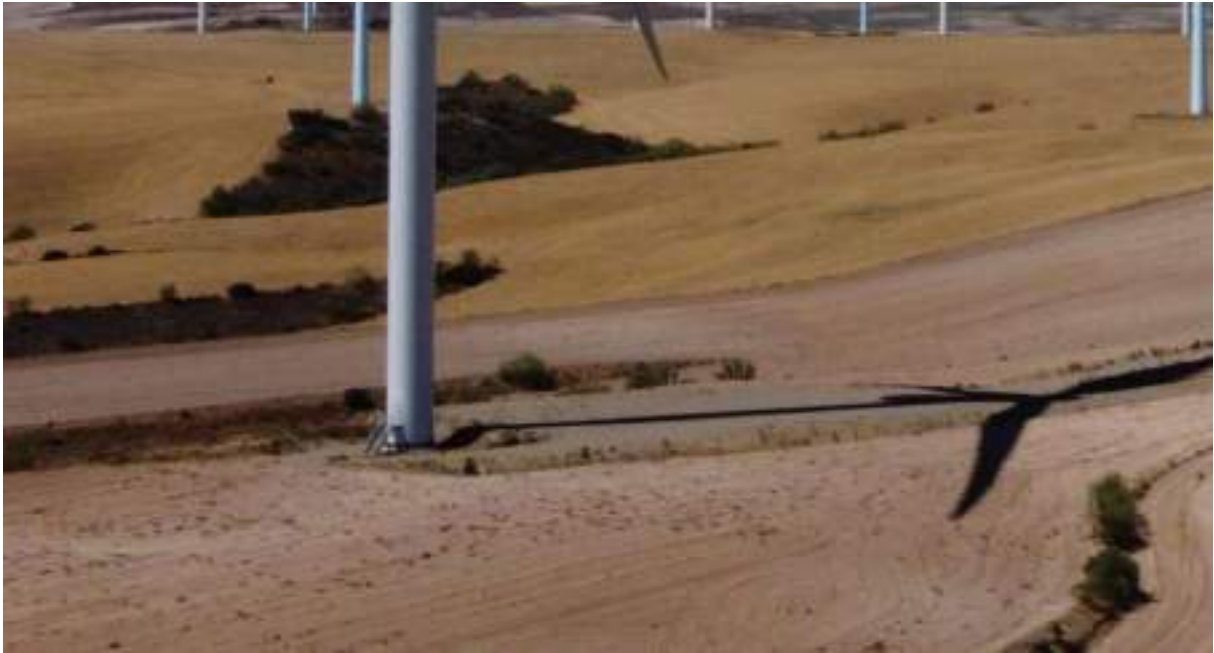
Foto nº5.: Plataforma del Aerogenerador T-05.
