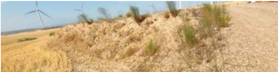
Foto nº27.: T-10: Hidrosiembra y plantación en el talud en terraplén de la plataforma.
