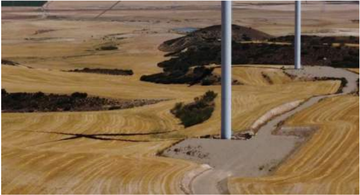
Foto nº11.: Plataforma del Aerogenerador T-11.
