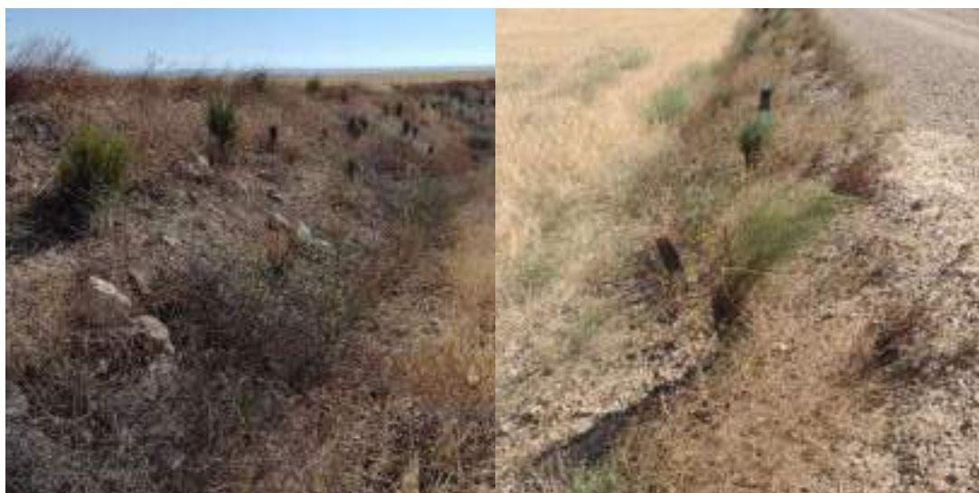
Foto nº29.: T-12: Plantación en el talud en terraplén del camino.
