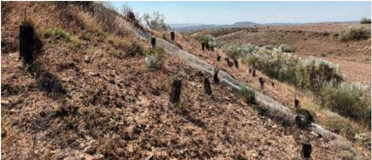
Foto nº24.: T-06: Plantación en el talud del terraplén de la plataforma.
