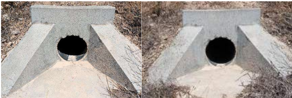
Foto nº35.: T-06: Drenaje del vial.
