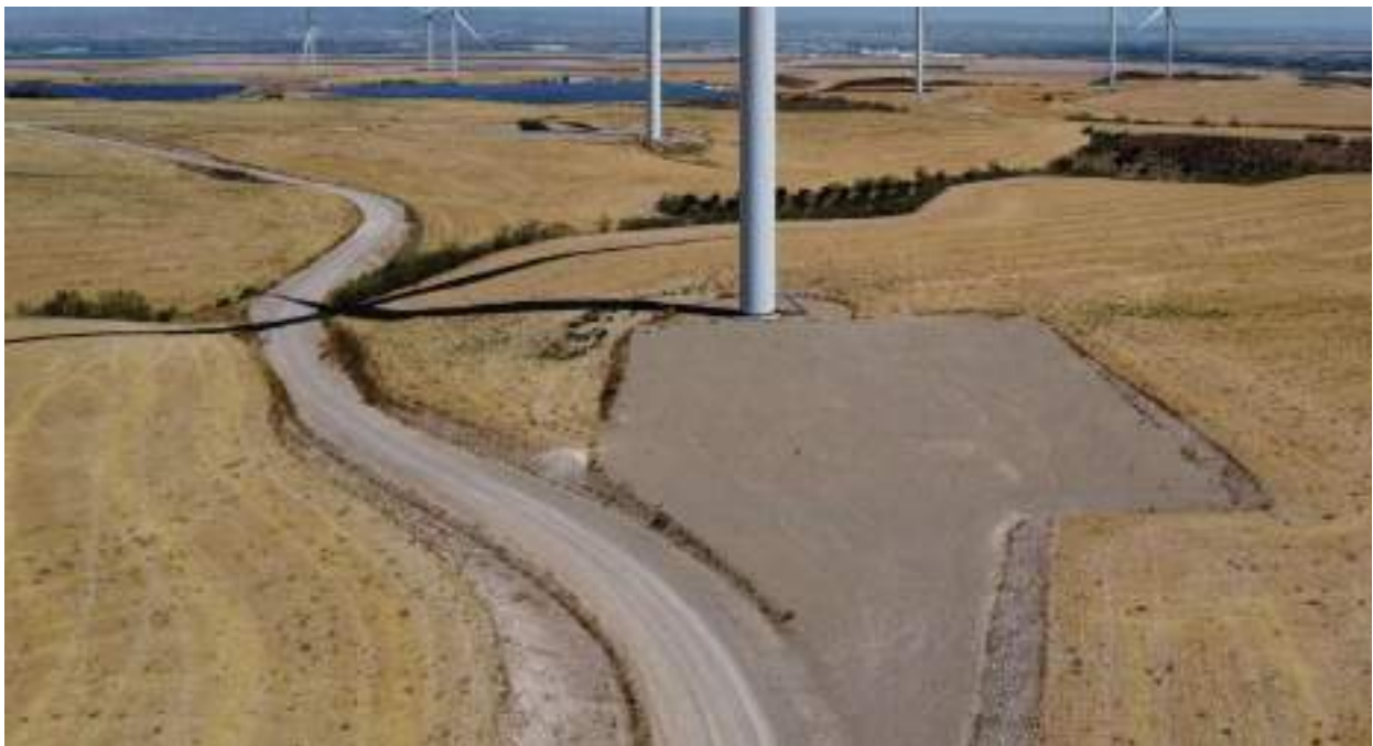
Foto nº8.: Plataforma del Aerogenerador T-08.
