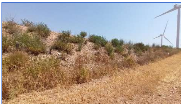
Estado general de los taludes restaurados. (T-07)
