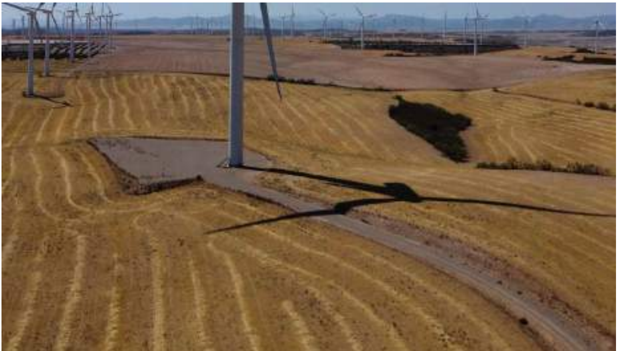
Foto nº4.: Plataforma del Aerogenerador T-04.
