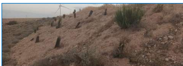
Estado general de los taludes restaurados. (T-13)
