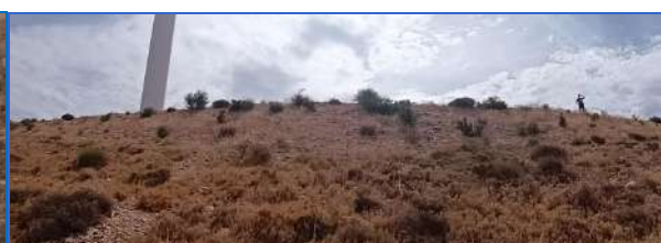
Estado general de los taludes restaurados. (T-14)
