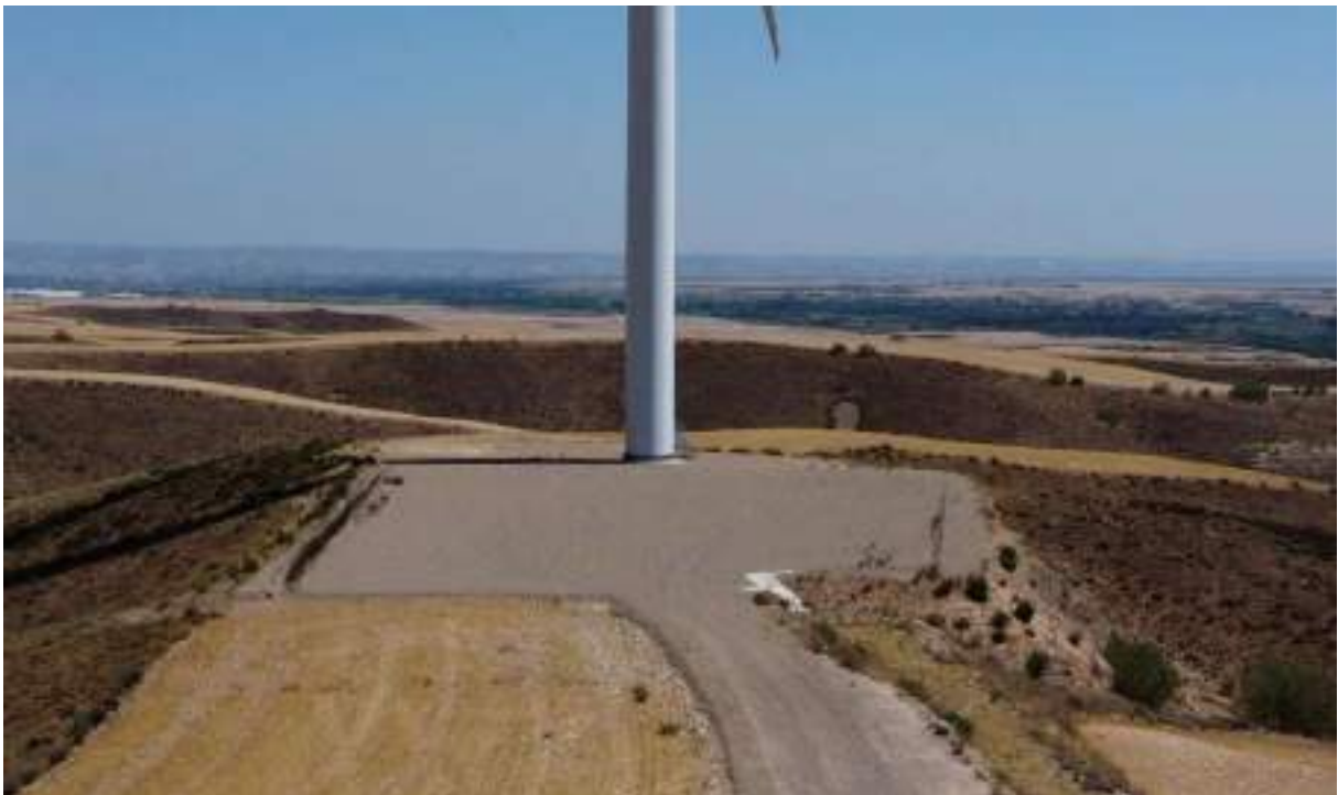
Foto nº14.: Plataforma del Aerogenerador T-14.
