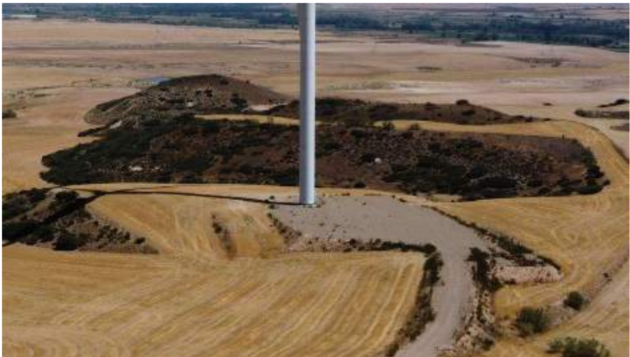
Foto nº12.: Plataforma del Aerogenerador T-12.
