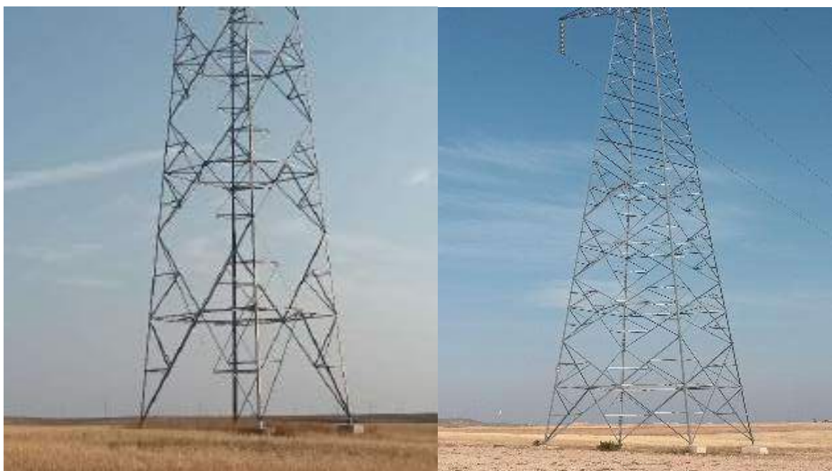
Foto nº16.: Estado general de los apoyos. Ejemplo del Apoyo nº 7 y nº 10 de la LAAT.
