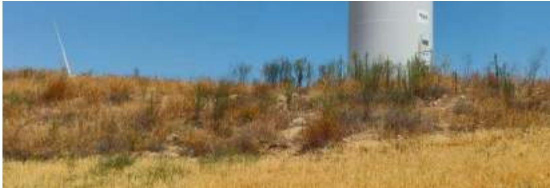
Foto nº26.: T-09: Hidrosiembra y plantación en el talud en terraplén de la plataforma.
