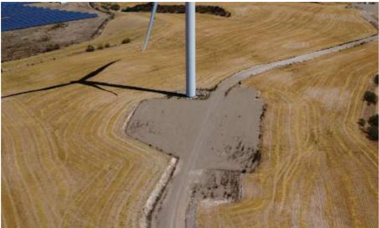
Foto nº10.: Plataforma del Aerogenerador T-10.
