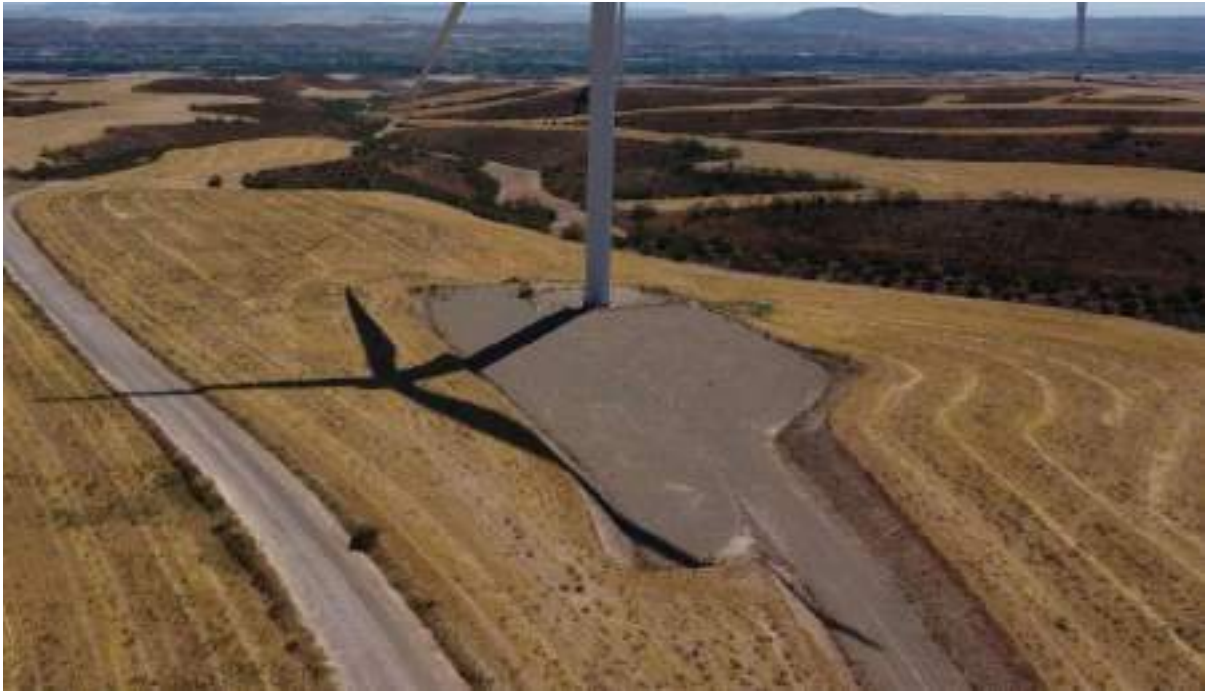
Foto nº9.: Plataforma del Aerogenerador T-09.
