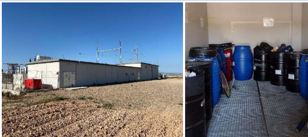
FOTOGRAFÍA DEL PUNTO LIMPIO
