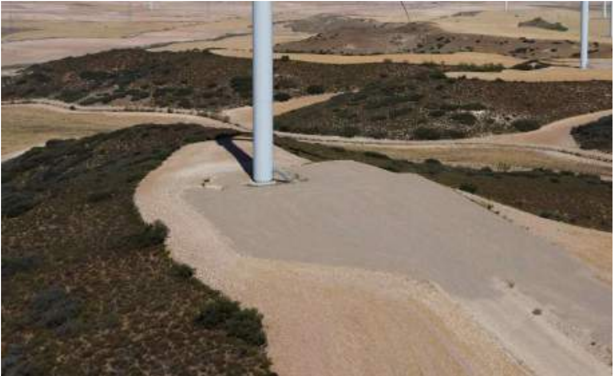
Foto nº1.: Plataforma del Aerogenerador T-01.
