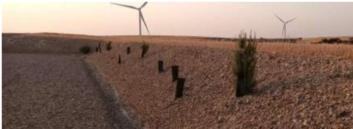
Foto nº20.: T-02: Plantación en el talud en desmonte de la plataforma.
