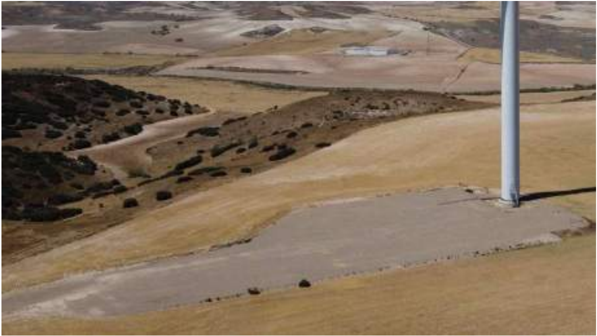
Foto nº3.: Plataforma del Aerogenerador T-03.
