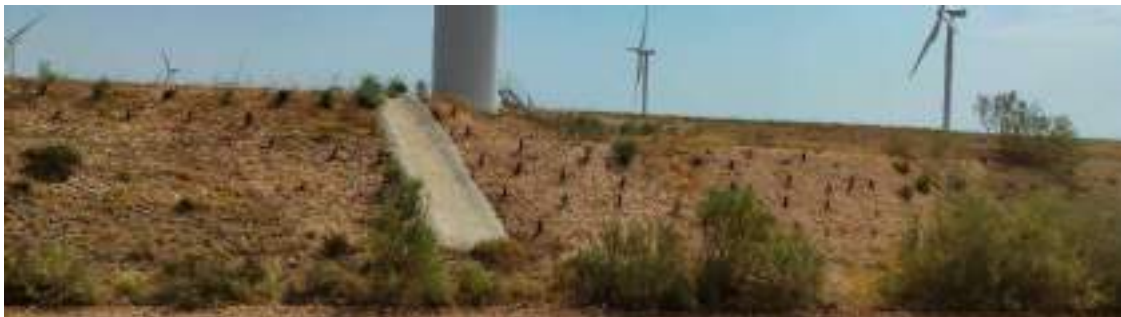
Foto nº34.: T-06: Canalización de agua para evitar escorrentías por el talud.
