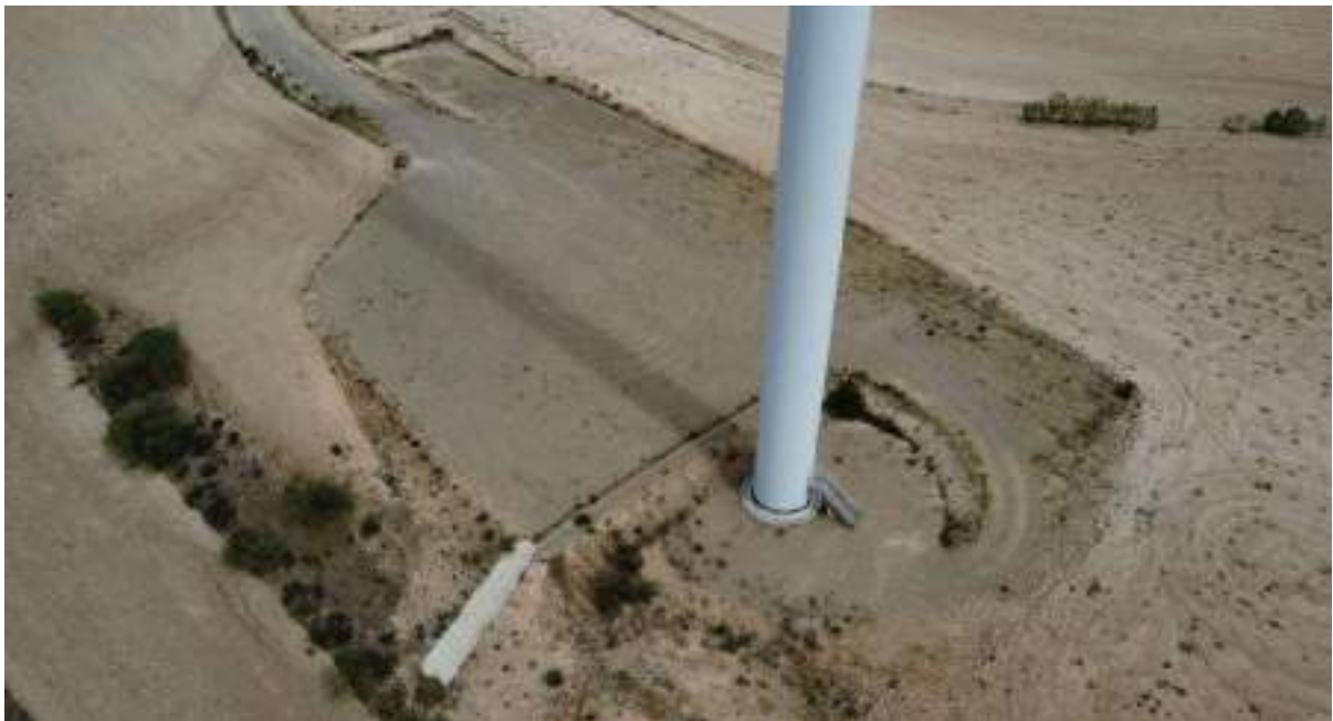
Foto nº6.: Plataforma del Aerogenerador T-06.
