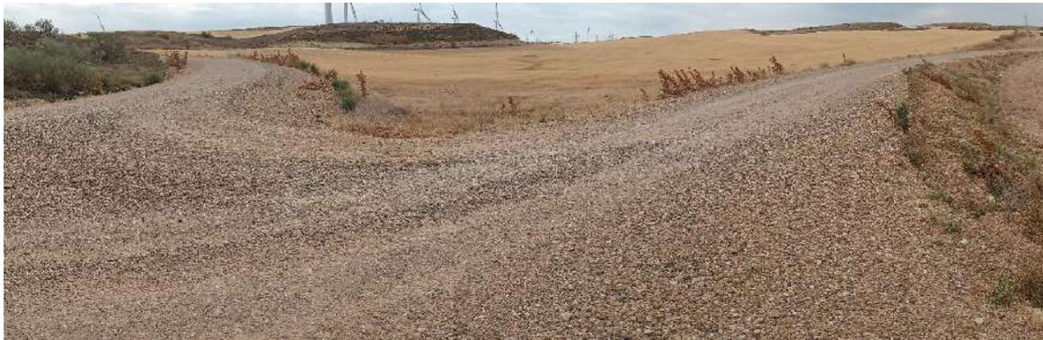
Foto nº20.: Drenaje del vial de acceso al PE.
