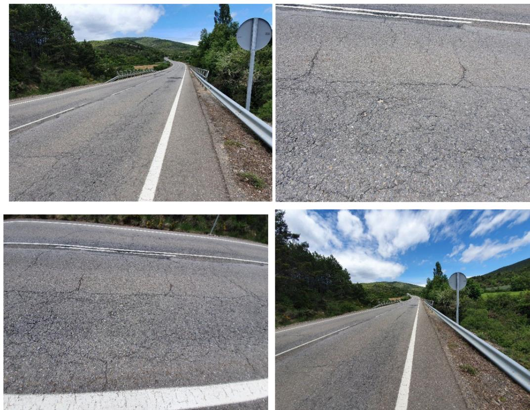
**Estado deteriorado del firme con agrietamientos y cuarteos en malla fina y gruesa**
