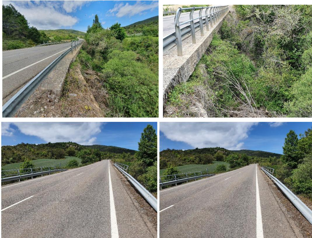
***Barreras de seguridad con perfiles IPN y altura menor de la debida***
