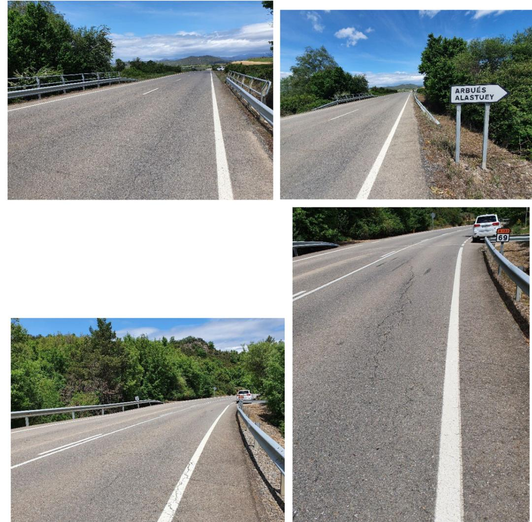
***Estado deteriorado del firme con agrietamientos y cuarteos en malla fina y gruesa***
