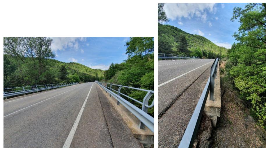
**Barreras de seguridad con perfiles IPN y altura menor de la debida**
