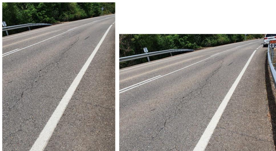
**Estado deteriorado del firme con agrietamientos y cuarteos en malla fina y gruesa**
