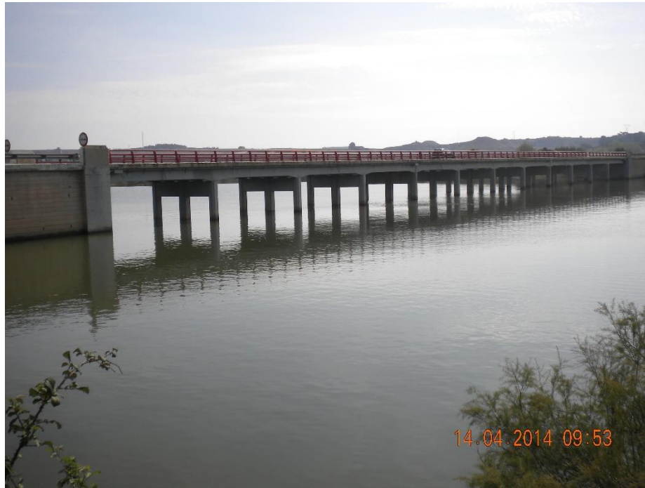
Puente sobre el Ebro
