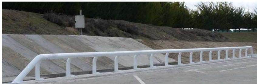
La altura total del sistema de contención es de 663 mm, considerada dicha altura con respecto al nivel de la acera (o suelo) sobre la que se va a instalar el pretil. La anchura total del sistema es de 338 mm.
