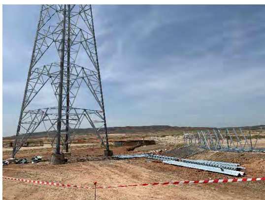
Figura 22 Jalonado de los accesos
