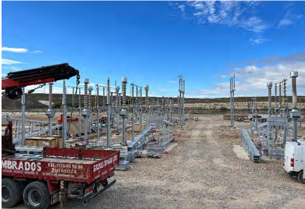
Figura 8 Montaje de la estructura de la CS Ave
