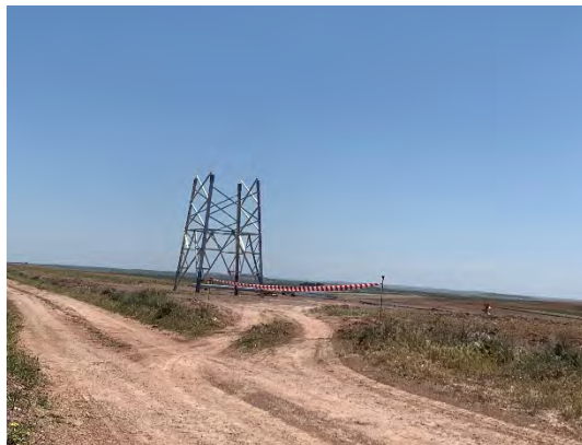
Figura 23 Jalonado de los accesos
