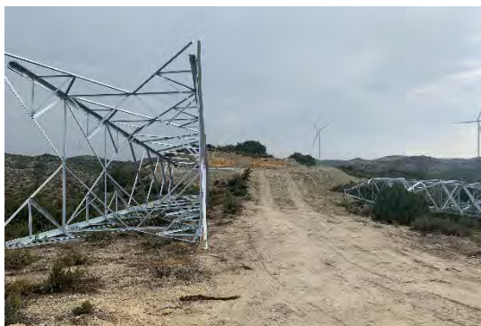
Figura 6 Montaje de los apoyos
