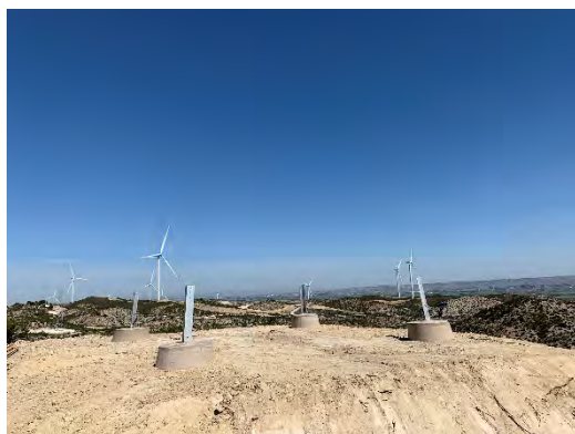
Figura 16 Labores de cimentación
