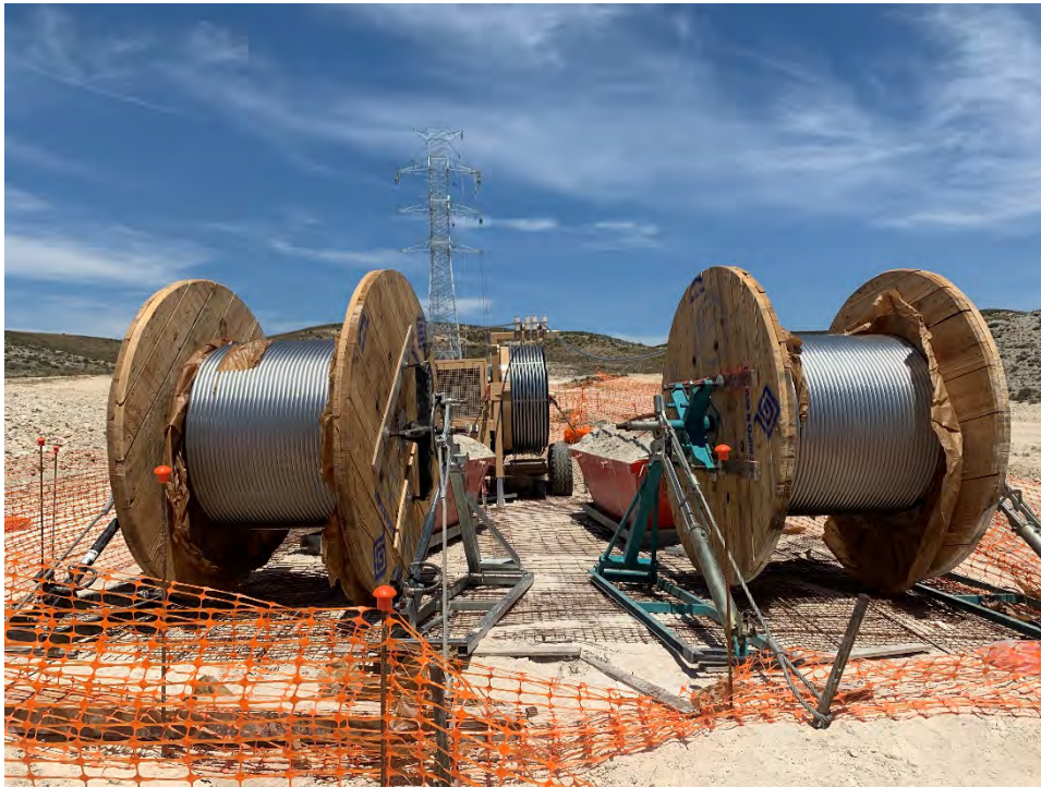
Figura 30 Tendido de cable de alta tensión
