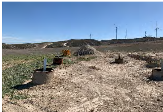
Figura 5 Cimentación de los apoyos
