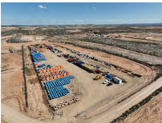
Figura 14 Zona de acopio del material de construcción
