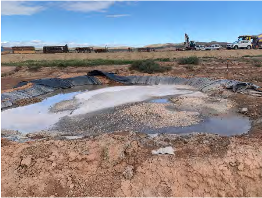
Figura 18 Lavadero de cubas de hormigón
