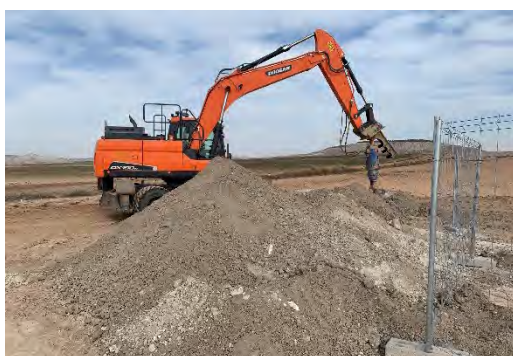
Figura 2 Acopio del material de excavación
