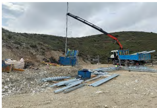
Figura 7 Izado de los apoyos
