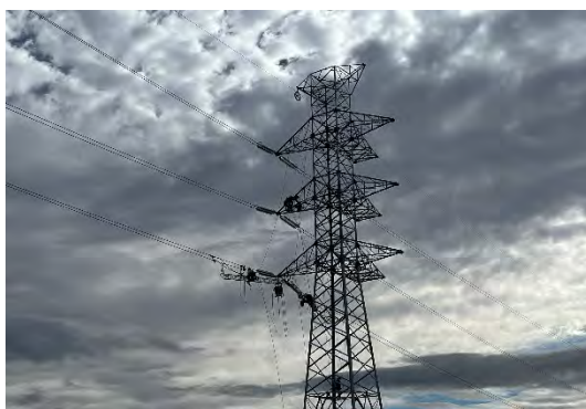
Figura 9 Tendido de cable de alta tensión
