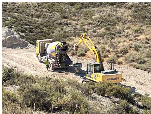
Figura 17 Labores de cimentación
