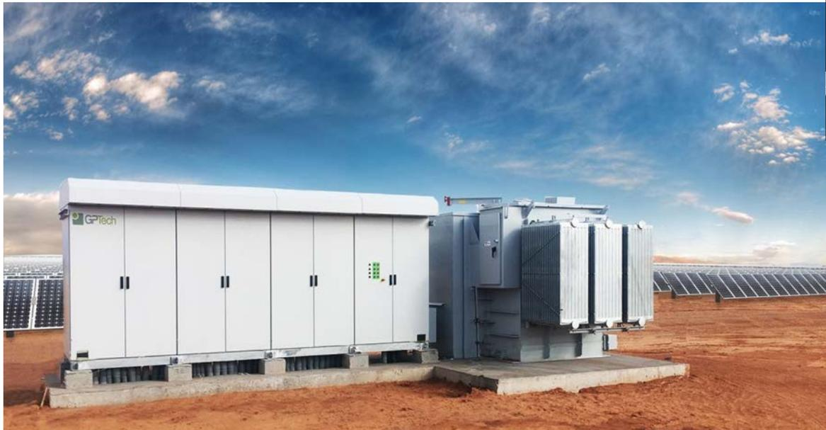
En estas unidades la tensión de la energía suministrada es elevada de 800 V a 15.000V. Se han diseñado de exterior para evitar los problemas que la Temperatura puede causar a su rendimiento.
