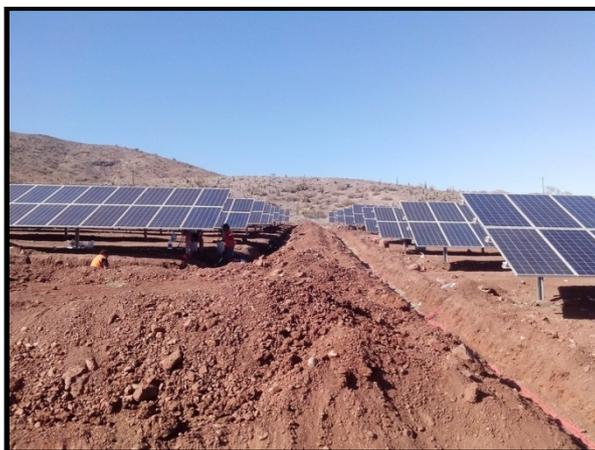
El excedente del material no reutilizado será recogido, transportado y almacenado por los vehículos internos de la construcción del parque desde su lugar de extracción hasta una zona de almacenamiento intermedio denominadas "zona de acopio de material excedente de excavación".
