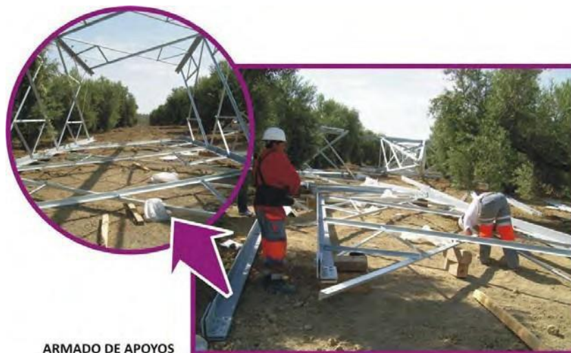
ARMADO DE APOYOS
