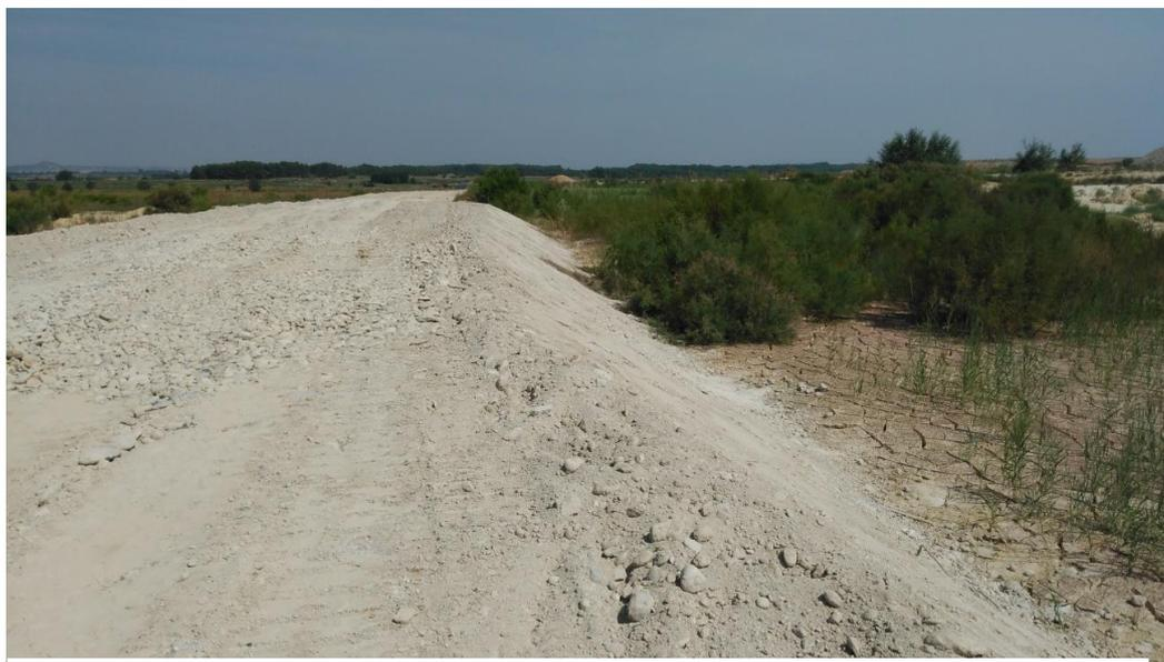
Foto 2. Dique de contención por donde pasa un camino de tierra para acceder a las balsas. Se pueden ver las balsas a la derecha de la foto.
