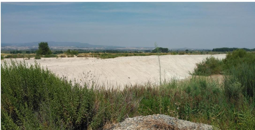
Foto 1. Dique de contención de las balsas de lodos.
