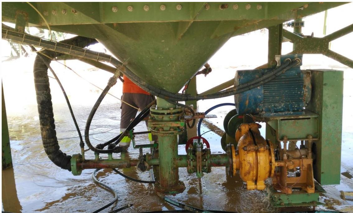
Foto 9. A la derecha se puede ver el motor y la bomba que se utiliza para bombear los lodos que sedimentan al fondo del tanque por la tubería que va hasta las balsas.
