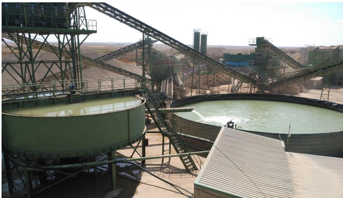
Foto 10. A la izquierda se puede ver el tanque de clarificación. Este presenta una tubería que descarga el agua limpia hacia una segunda balsa. Esta segunda balsa será utilizada para reintroducir el agua recuperada en el proceso de lavado.
