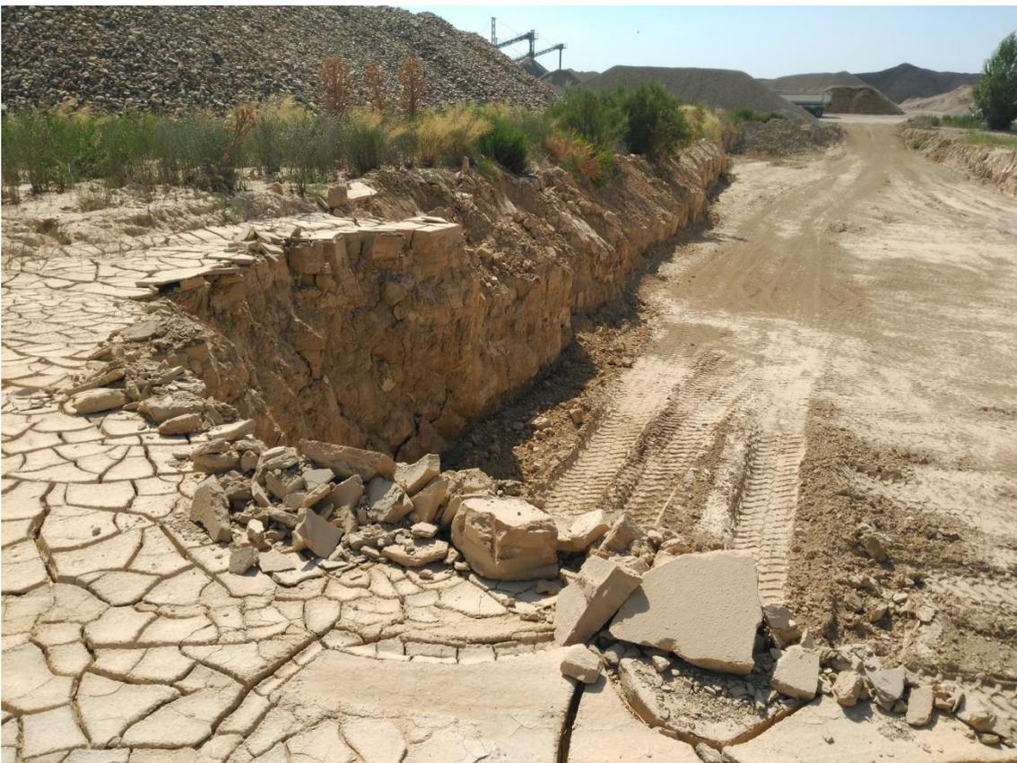
Foto 6. Zona de la balsa de lodos donde se ha extraído parte del material para la restauración de algunas de las parcelas de la actividad extractiva. Se puede ver que los lodos tienen una altura de 3 m aproximadamente.
