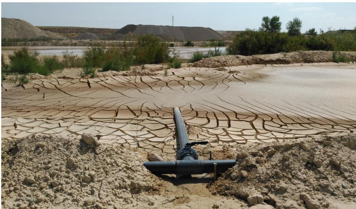
Foto 4. Una de las salidas de la tubería que conecta el tanque clarificador con las balsas de lodos.
