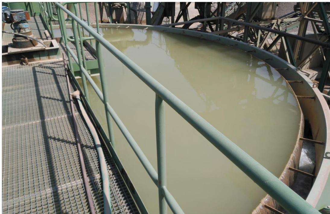
Foto 8. Tanque de clarificación donde se puede ver la ranura por la que se derrama el agua limpia.
