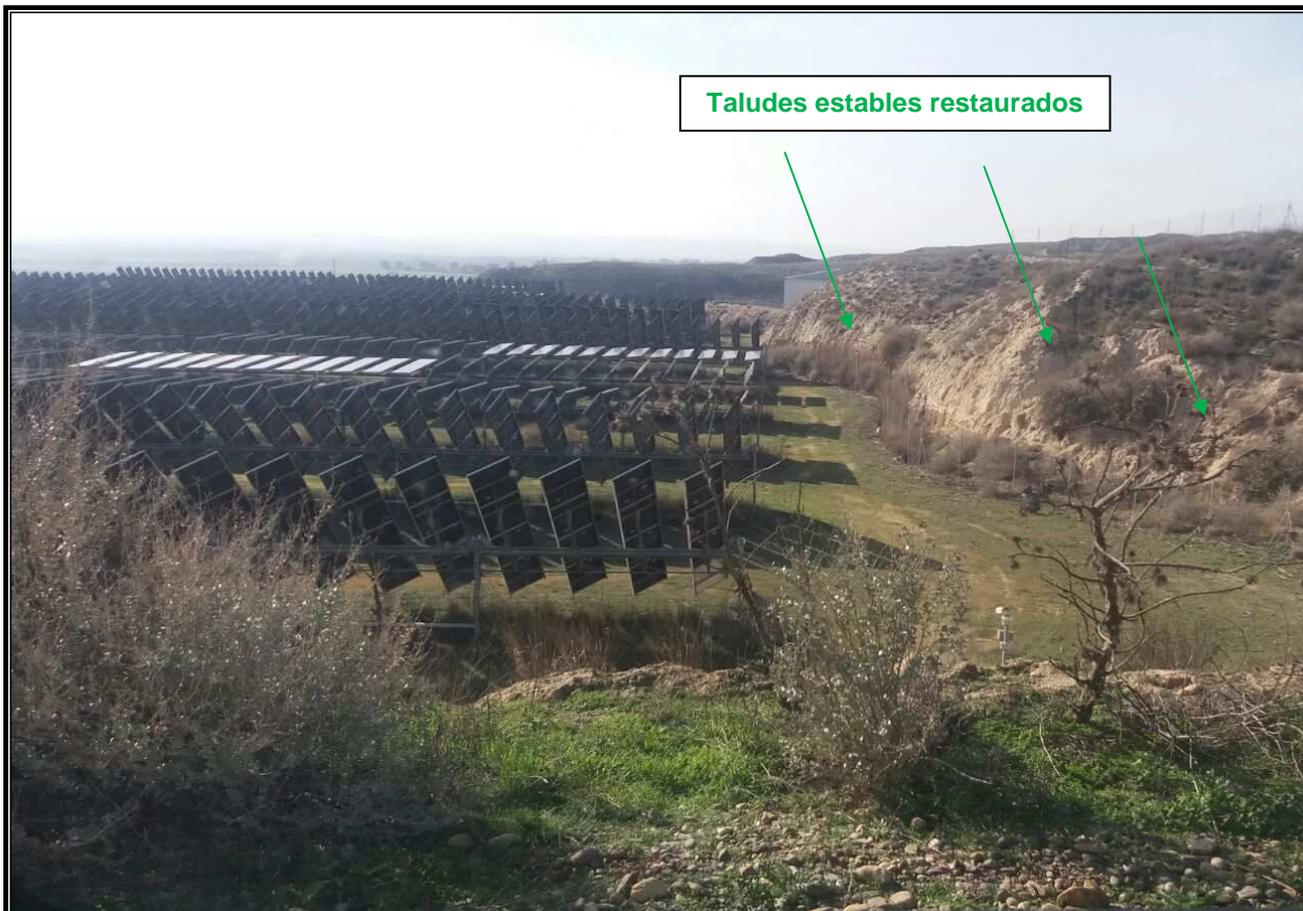
Taludes restaurados en la zona del Parque Fotovoltaico en el que se aprecia inclinación de la cara del talud y vegetación sobre ella.
