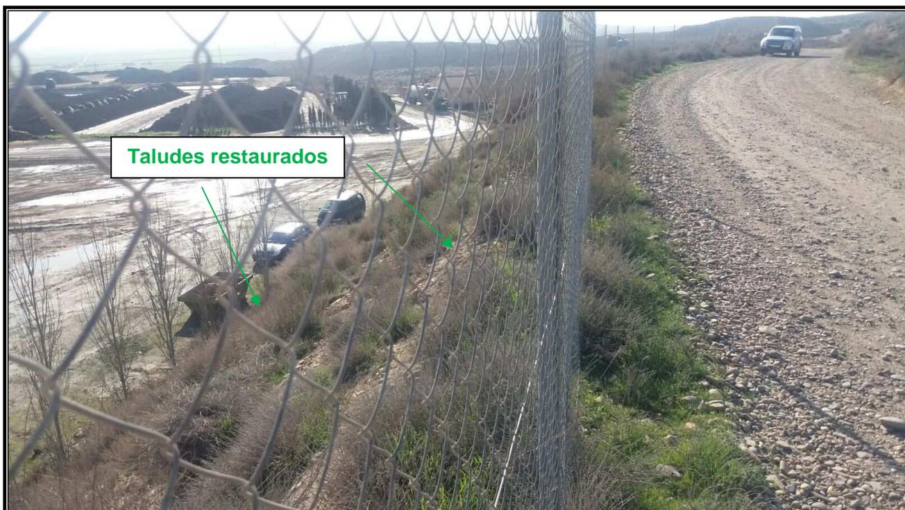
Los taludes no modificados en los que se conserva la restauración ejecutada por **TRANSPORTES, ÁRIDOS Y EXCAVACIONES LABORDA, S.L.** se encuentran integrados con el entorno debido a la inclinación dada a la cara del talud en su momento y la existencia de vegetación.
