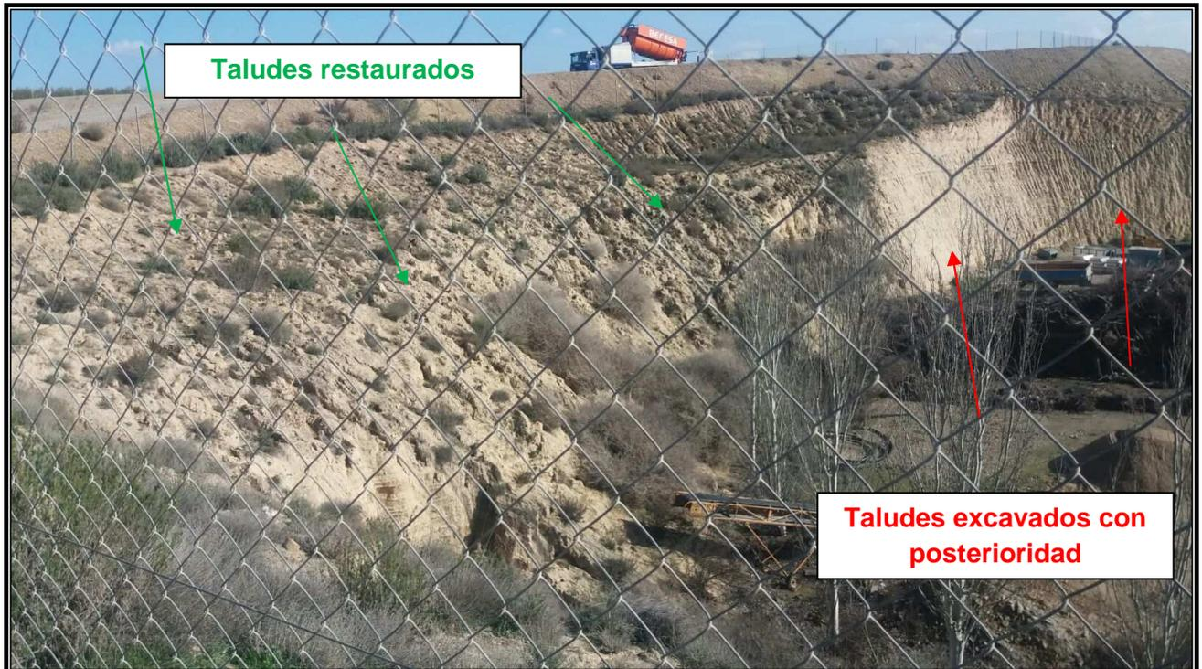
La diferencia entre taludes restaurados y taludes excavados después de la restauración ejecutada por **TRANSPORTES, ÁRIDOS Y EXCAVACIONES LABORDA, S.L.** es tan evidente que no ofrece dudas de la modificación realizada.
