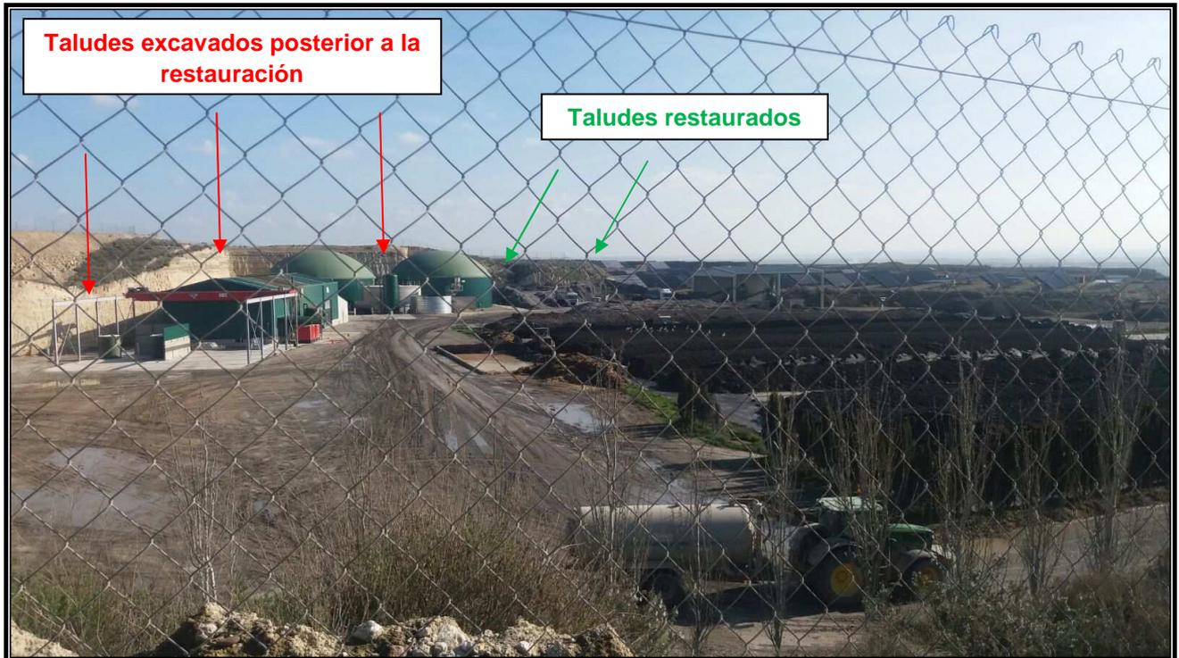
Al fondo, en el centro de la fotografía, se aprecian los taludes restaurados en los que se asienta vegetación, diferenciándose con claridad los taludes excavados con posterioridad a la restauración a su izquierda, presentando una total verticalidad ( talud de  $90^\circ$  ) y, como es lógico, ausencia de vegetación en la cara del talud.
