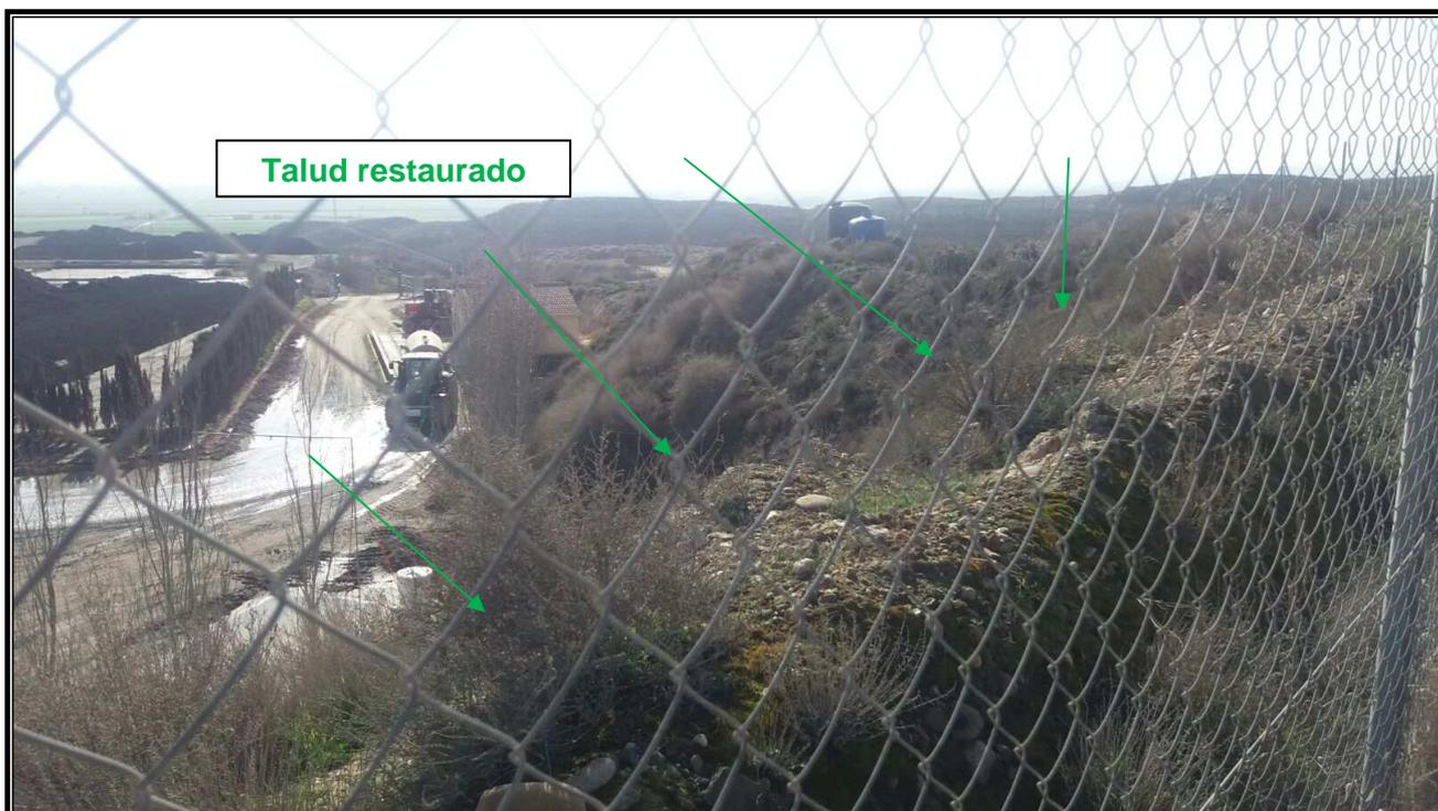
Los taludes finales restaurados de la *Gravera "LABORDA"*, que no han sido objeto de excavación posterior, se identifican por una inclinación estable de la cara del talud y la presencia de vegetación.
