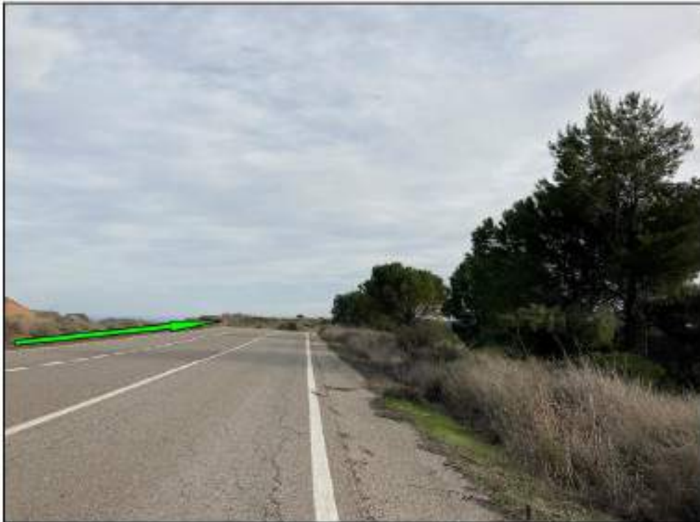
Fotografía nº 5. “Nuevo tramo subterráneo” de la línea eléctrica sobre servidumbre de la Antigua Carretera N-II. “La Cuesta de Fraga” (vista este).
