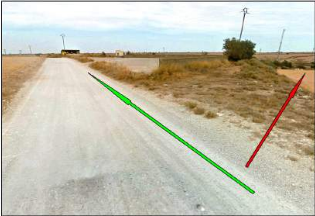
Fotografía nº 1. “Nuevo tramo subterráneo” de la línea eléctrica dirección norte (Verde) sobre Cordel de los Arcos y “Tramo aéreo inicial eliminado” (Rojo) dirección este.
