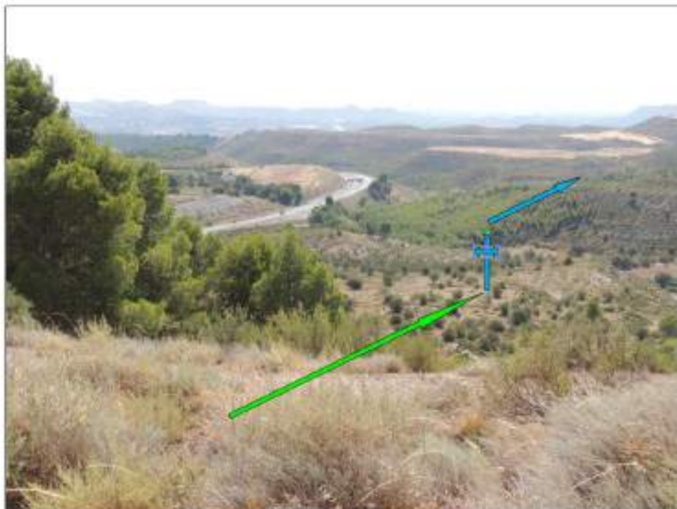
Fotografía nº 10. “Nuevo tramo subterráneo” de la línea eléctrica sobre pastizal-matorral degradado desde servidumbre de la Antigua Carretera N-II (Verde) al entronque con línea aérea, Apoyo 12 (Azul) (vista este).
