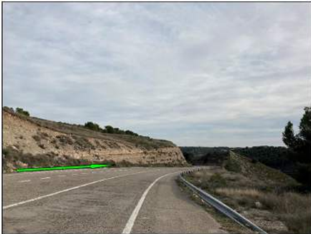
Fotografía nº 7. “Nuevo tramo subterráneo” de la línea eléctrica sobre servidumbre de la Antigua Carretera N-II. “La Cuesta de Fraga” Primera curva dcha. sentido bajada (vista este).
