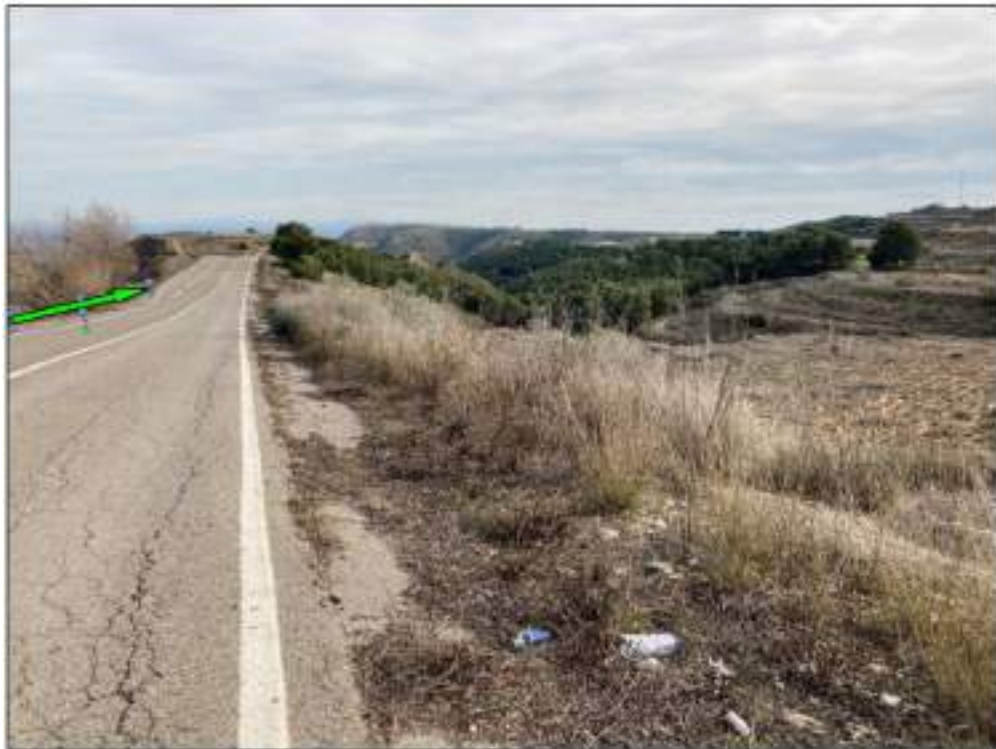
Fotografía nº 4. “Nuevo tramo subterráneo” de la línea eléctrica sobre servidumbre de la Antigua Carretera N-II. “La Cuesta de Fraga” (vista este).
