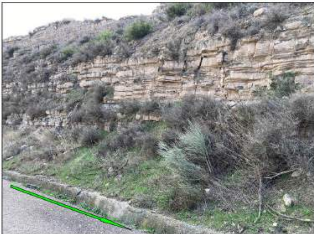
Fotografía nº 8. “Nuevo tramo subterráneo” de la línea eléctrica sobre servidumbre de la Antigua Carretera N-II. “La Cuesta de Fraga” Segunda curva dcha. sentido bajada (vista oeste).
