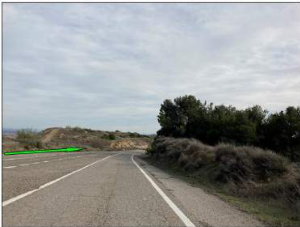
Fotografía nº 6. “Nuevo tramo subterráneo” de la línea eléctrica sobre servidumbre de la Antigua Carretera N-II. “La Cuesta de Fraga” Primera curva dcha. sentido bajada (vista este).
