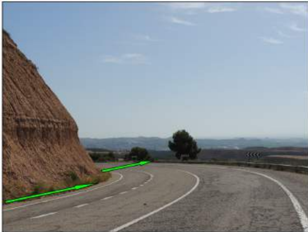
Fotografía nº 9. “Nuevo tramo subterráneo” de la línea eléctrica sobre servidumbre de la Antigua Carretera N-II. “La Cuesta de Fraga” Segunda curva izda. sentido bajada. Salida dirección apoyo aéreo nº 12 (vista este).
