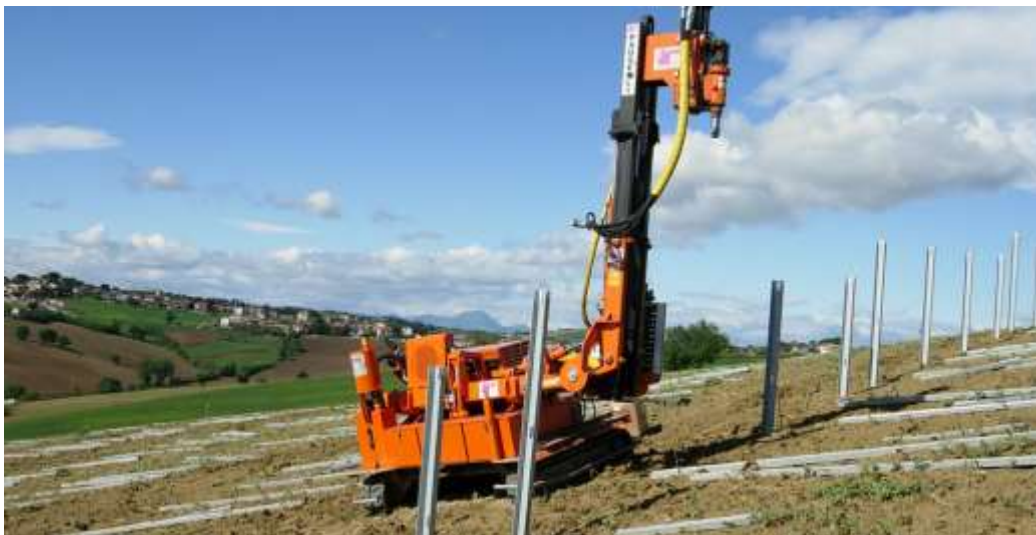
Ilustración 6: Máquina hinca postes. Fuente: Pauselli Group
