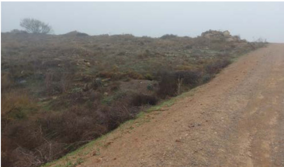
Figura. 8. Detalle de los pocos tramos del camino, por donde está proyectado el trazado soterrado de la línea eléctrica de evacuación de 30 kV, en cuya margen se observa vegetación natural y no campo de cultivo. Esta vegetación se compone de sisallo, esparto, sosera y algún ejemplar de retama
