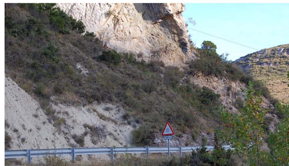
Foto nº 36.- Detalle de talud generado por la carretera A-132, se aprecia la verticalidad del mismo.
