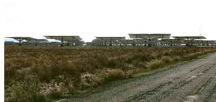
Parcela con paneles solares.
