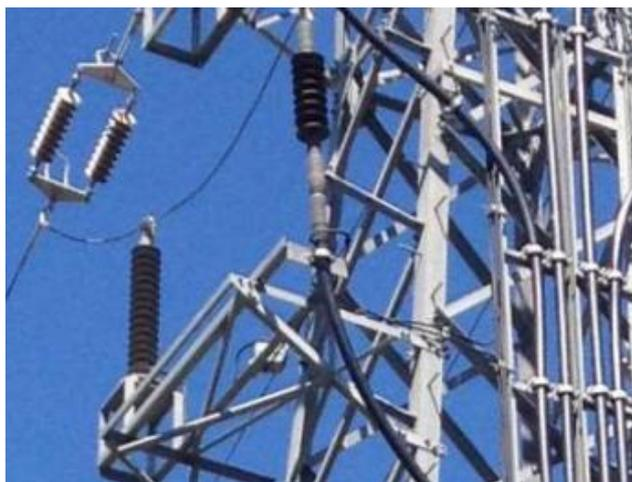
Figura 7. Detalle sujeción de los cableados secos en apoyo tipo PA/S
