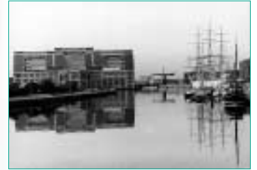
The offices of the „Communauté Urbaine de Dunkerque“, France
