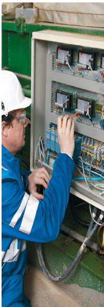
Mantenimiento en Central de Ciclo Combinado (Castelnou, Teruel)
