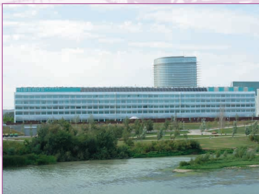
Instalación solar térmica en Hotel Hiberus en Zaragoza
