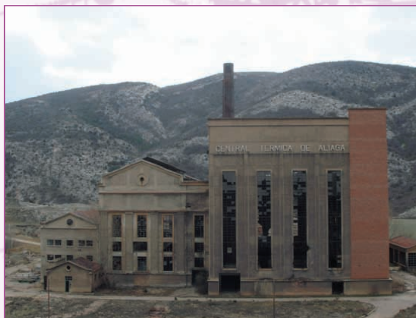
Edificio antigua central térmica de Aliaga (Teruel)
