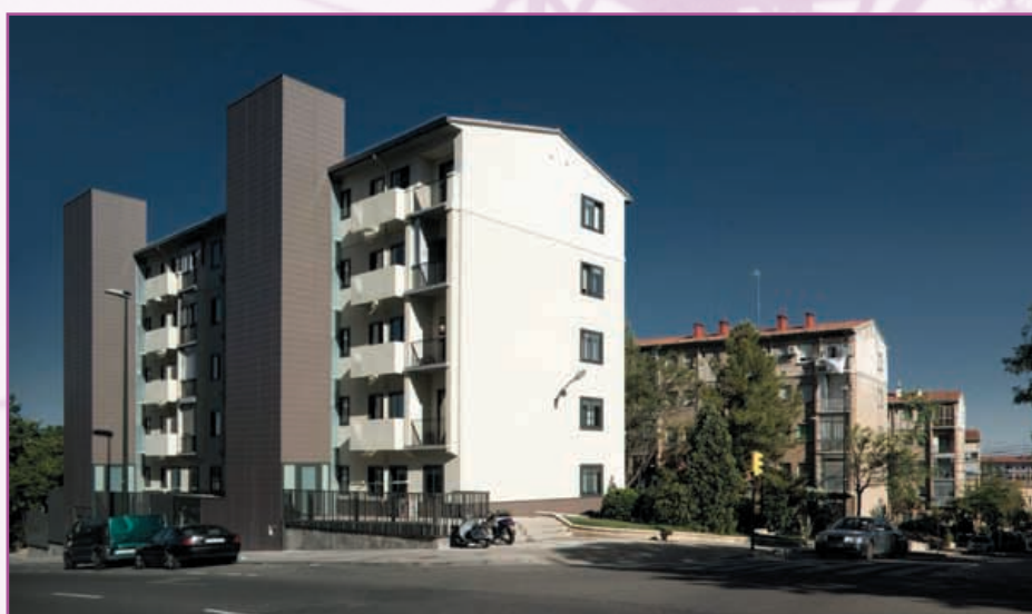
Rehabilitación de la envolvente térmica del Edificio Alférez Rojas (Zaragoza)
