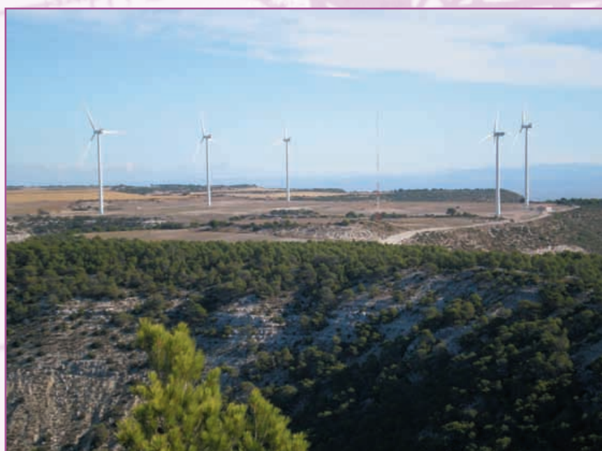
Parque Eólico Sancho Abarca (Tauste, Zaragoza)
