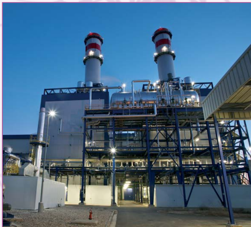
Central de ciclo combinado "Castelnou" de 790 MW
