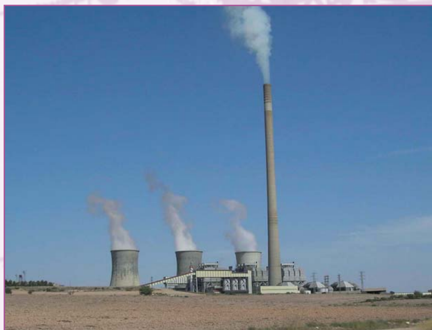
Central térmica "Teruel" de 1.101 MW
