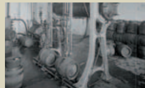
Llenado de bariles LA ZARAGOZANA
