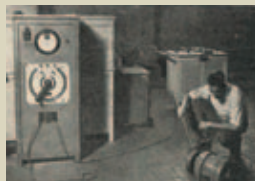
Detalle fábrica SCHINDLER
