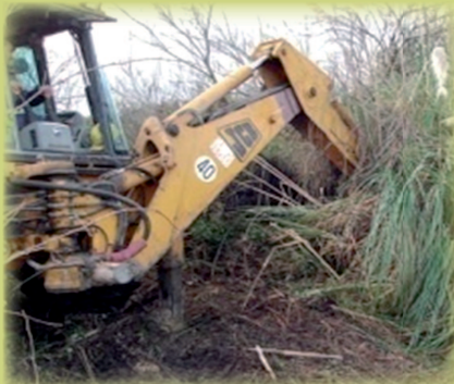
Eliminación de carrizo de la Pampa. En la Costa Cantábrica se dedica un gran esfuerzo a controlarla y Andalucía ha eliminado unas 600 tm (en la foto).
