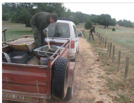
Sujetando los pivotes perimetrales de la Laguna
