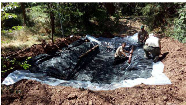
Adecuación de una balsa-charca en Dornaque
