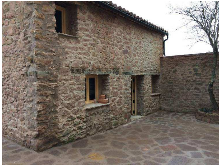
Acondicionamiento de refugio en Masía de Ligros
